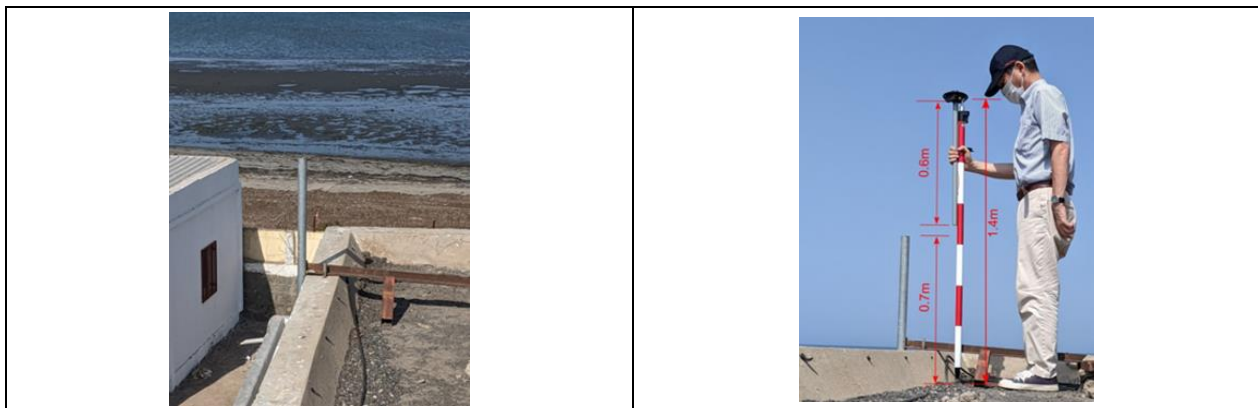
Figure 4-35 Mât et prises de courant mis en place par la partie djiboutienne
