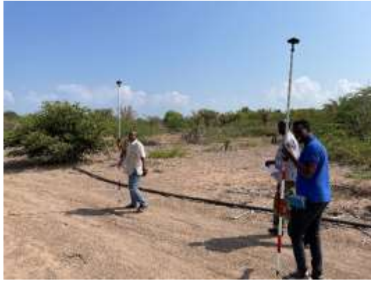
RTK 観測作業
