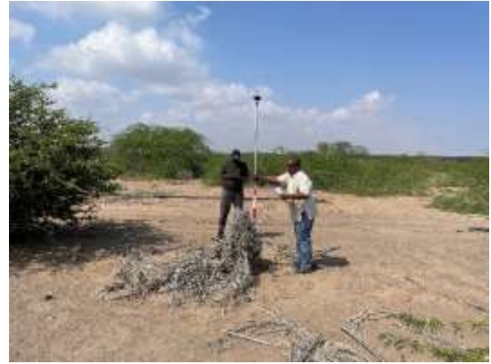
RTK 観測作業
