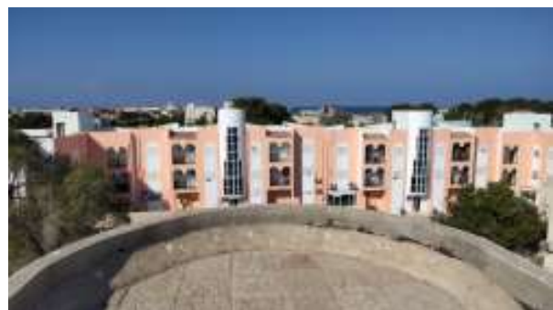
建設予定の Domaines の屋上
