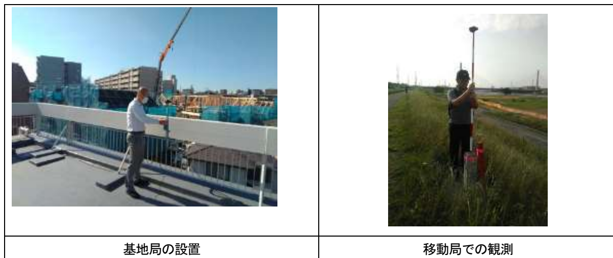
図 4-33 RTK 測量の実施
