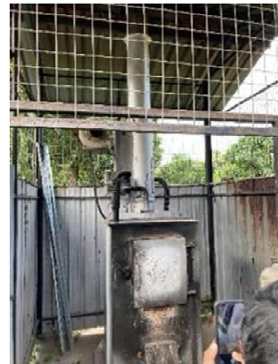
エンビリピティヤ病院の既存焼却炉の様子
