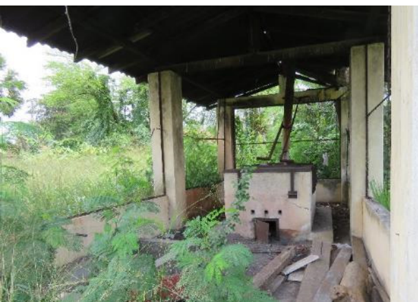
プッタラム病院の既存焼却炉の様子
