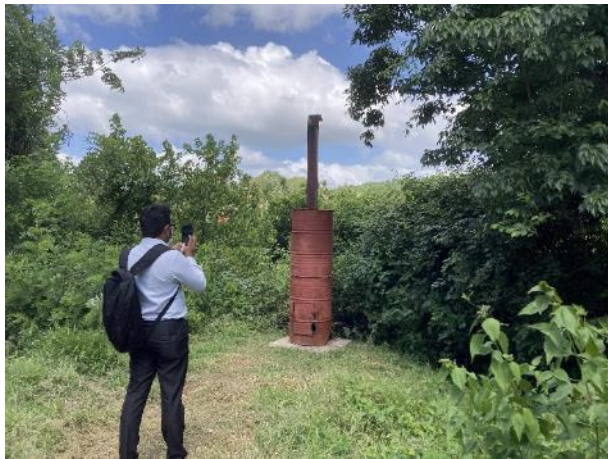
ナクルガムワ病院の 既存焼却炉（ドラム缶製）の様子
