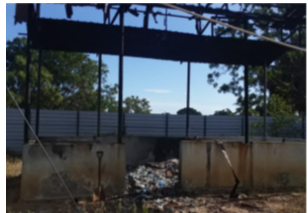
キリノッチ病院の野積みされた医療廃棄物
