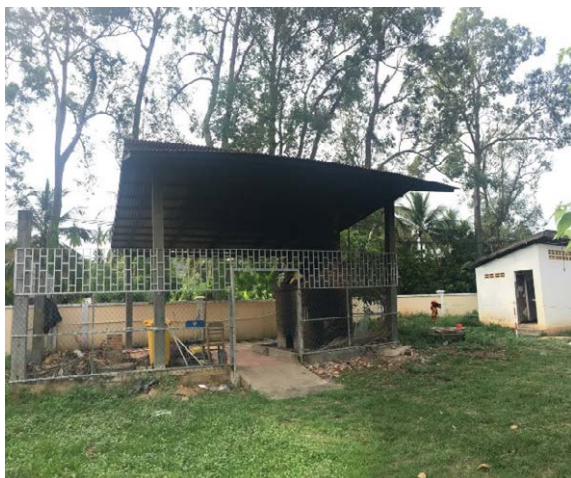
チョロン病院の既存焼却炉 (レンガ製)の様子
