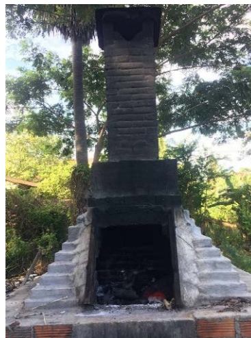
スベイチェック病院の既存焼却炉 (レンガ製)の様子
