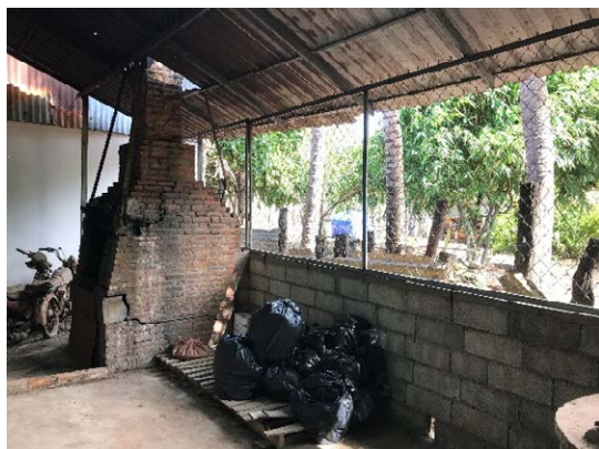
ブノンスロック病院の既存焼却炉 (レンガ製)の様子
