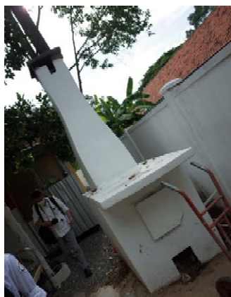
カオタム病院の既存焼却炉 (コンクリート製)の様子
