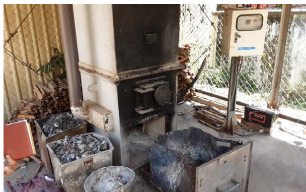
ネアックルン病院の既存焼却炉 (旧機械式)の様子
