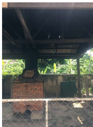
クラチエ州病院の既存焼却炉 (レンガ製)の様子
