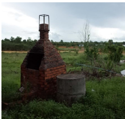
ブナイフセンカオスラ病院の既存焼却炉 (レンガ製)の様子
