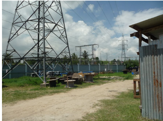
ウブンゴ変電所増設予定地（構内）
