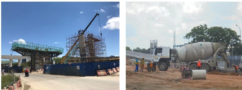
図 3-2-1-4.1 現地建設工事の様子
