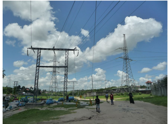
ウブンゴ変電所増設予定地（構外）
