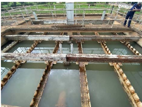
沈殿池 (Kapolet 浄水場)
