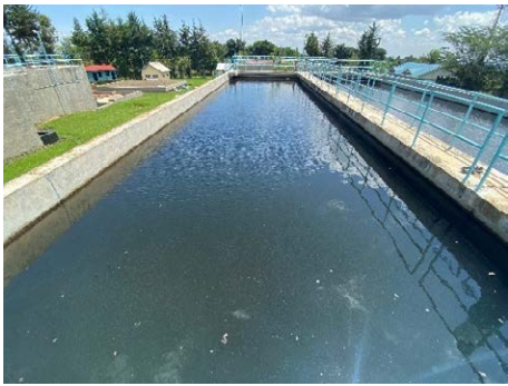
フロック形成池 (Kanyoni 浄水場)
