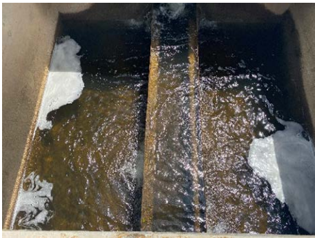
急速ろ過池 (Kanyoni 浄水場)
