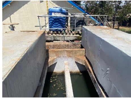
薬品混和池・フロック形成池 (Isiolo 浄水場)
