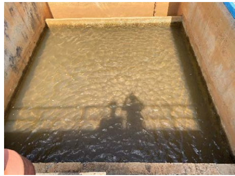
急速ろ過池 (Kiawambeu 浄水場)
