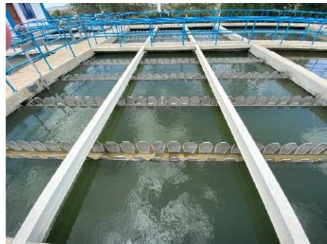
沈殿池 (新 Mavoko 浄水場)
