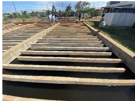
フロック形成池 (Mwangaza 浄水場)
