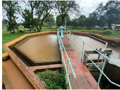
薬品混和池・フロック形成池 (Mereroni 浄水場)
