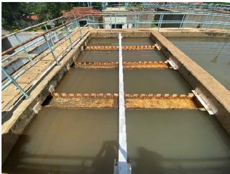
沈殿池 (Bungoma 浄水場)
