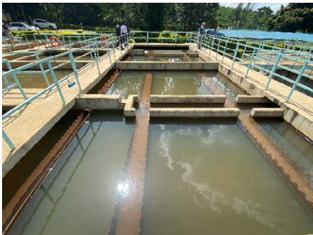
沈殿池 (Juja 浄水場)
