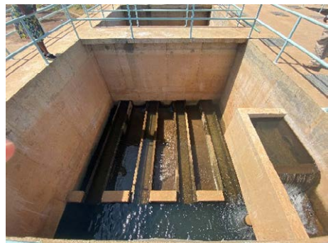
急速ろ過池 (Mwangaza 浄水場)
