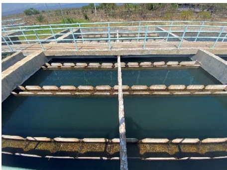
沈殿池 (Mwangaza 浄水場)
