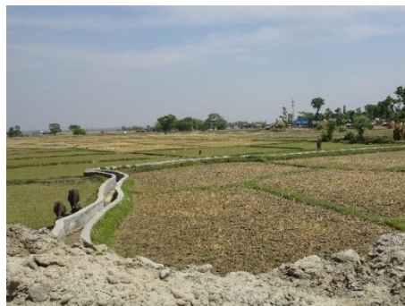
中流地区にあるJankatta Minor水路上流部（珍しいコンクリートフルーム型の水路）
