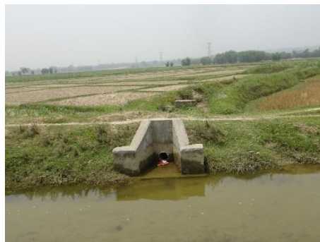
上流地区にあるOdraha支線水路上流部の分土工と三次水路（分水ゲートは設置されていない）
