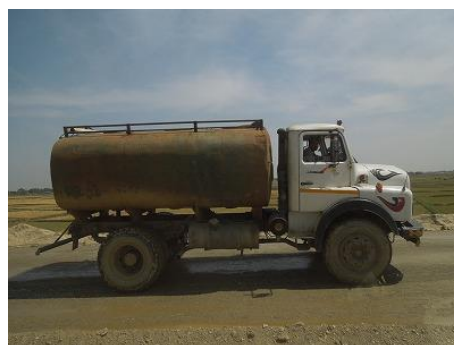
Postal Highway Projectによる路面散水の例
