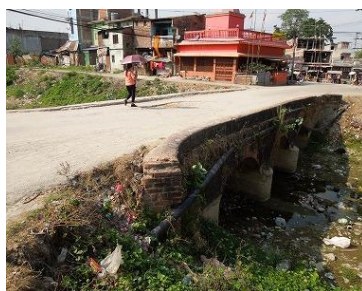
CCB03 (光ファイバーケーブル: ネパールテレコムが管轄)
