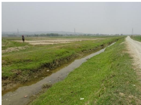
上流地区にあるOdraha支線水路上流部（整備されている）
