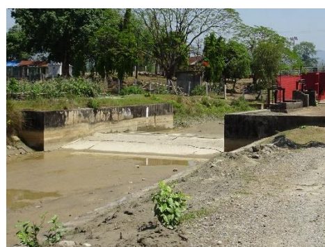
幹線用水路量水施設
