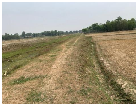
最下流地区にあるBanauli支線水路の中流部の支線水路と並行して走る3次水路
