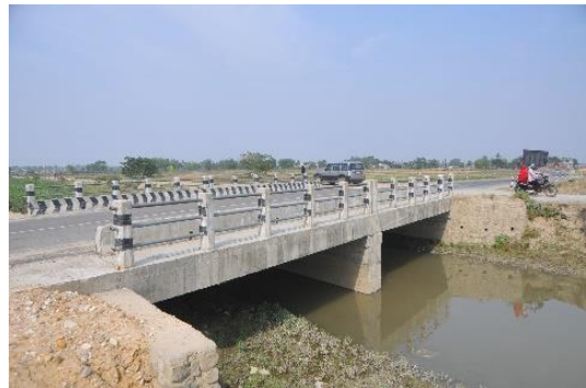
DORが近年整備した橋梁で、鉄筋コンクリートで整備され、状態も良好で整備対象から除外する。
