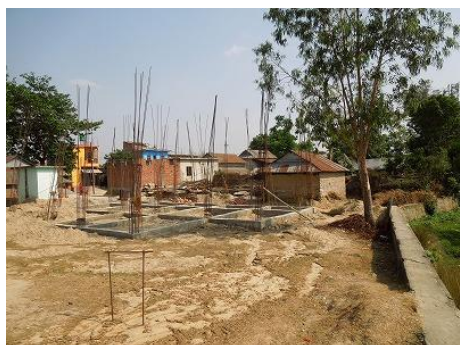
建設中の産婦人科
