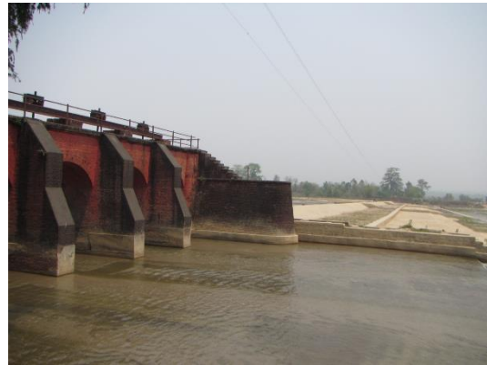
頭首工(固定堰と余水吐および土砂吐)
