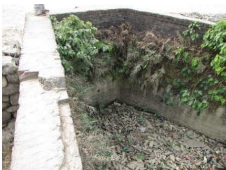
用水路サイホン流入入口清掃前
