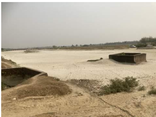
用水路サイホン(CUP3) : 調査対象における典型的な形状のサイホンである。乾期には河川流がないことが分かる。また、河床は上流から供給される土砂の堆砂がある。
