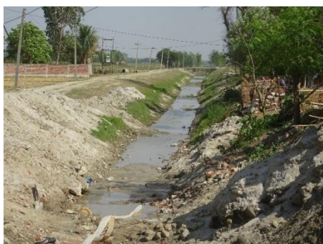
下流地区にあるNew Hanumannagar支線水路上流部（清掃されている）
