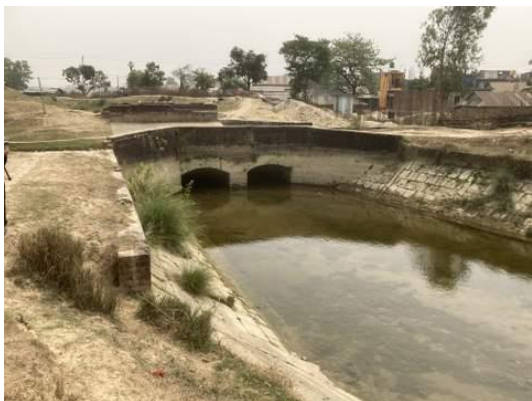
用水路サイホン (CUP2) : 幹線用水路の下流側から上流側を望む。
