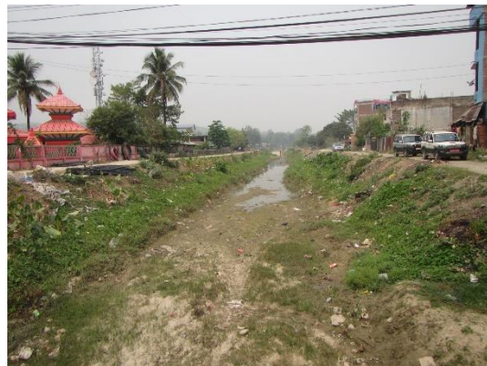
幹線用水路(上流側): 調査が乾期作の収穫時のため、ゲートが閉じられ用水は流れていない。
