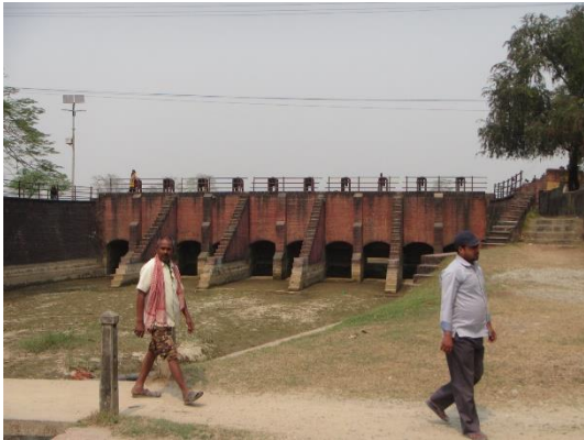
頭首工の取水工
