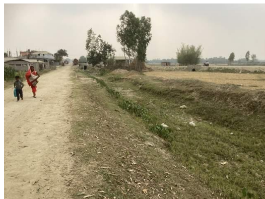
幹線用水路(下流側): 中間同様に水路底にも雑草が生えている。
