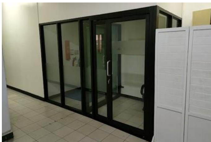
図 2.43 GC/HRMS 室の室温・湿度の維持のために設置された前室
