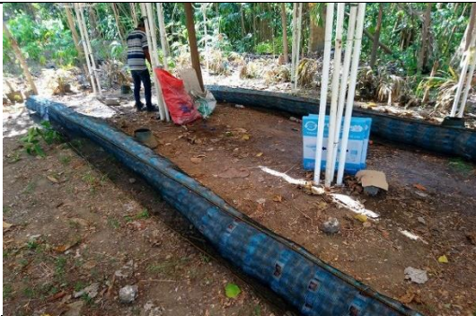
セブ市での廃 PET ボトルを利用した河川でのごみ回収フェンス (2019年3月)
