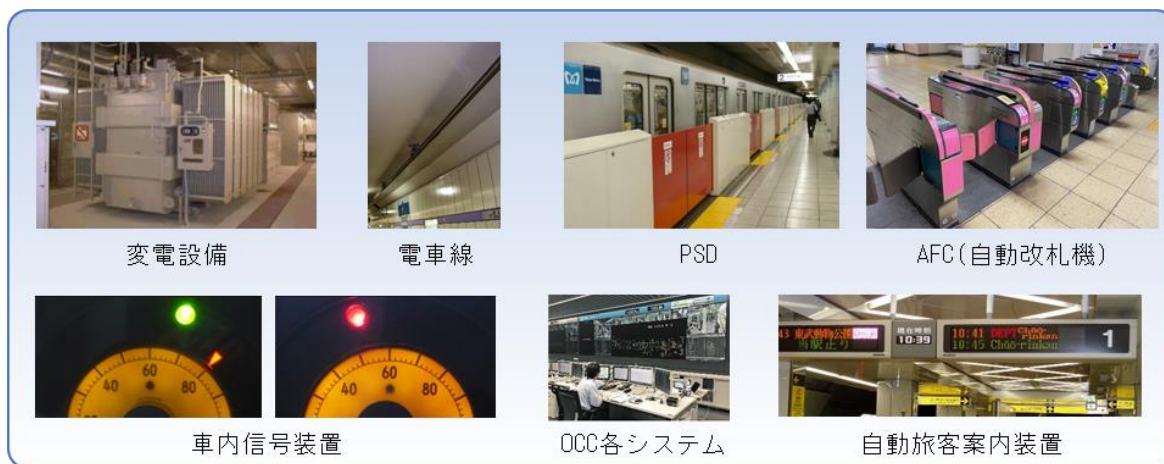
図 2-56 主な鉄道電気施設
