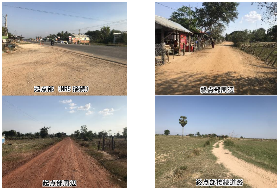
図 3.2-15 道路状況写真 (PS-3)
