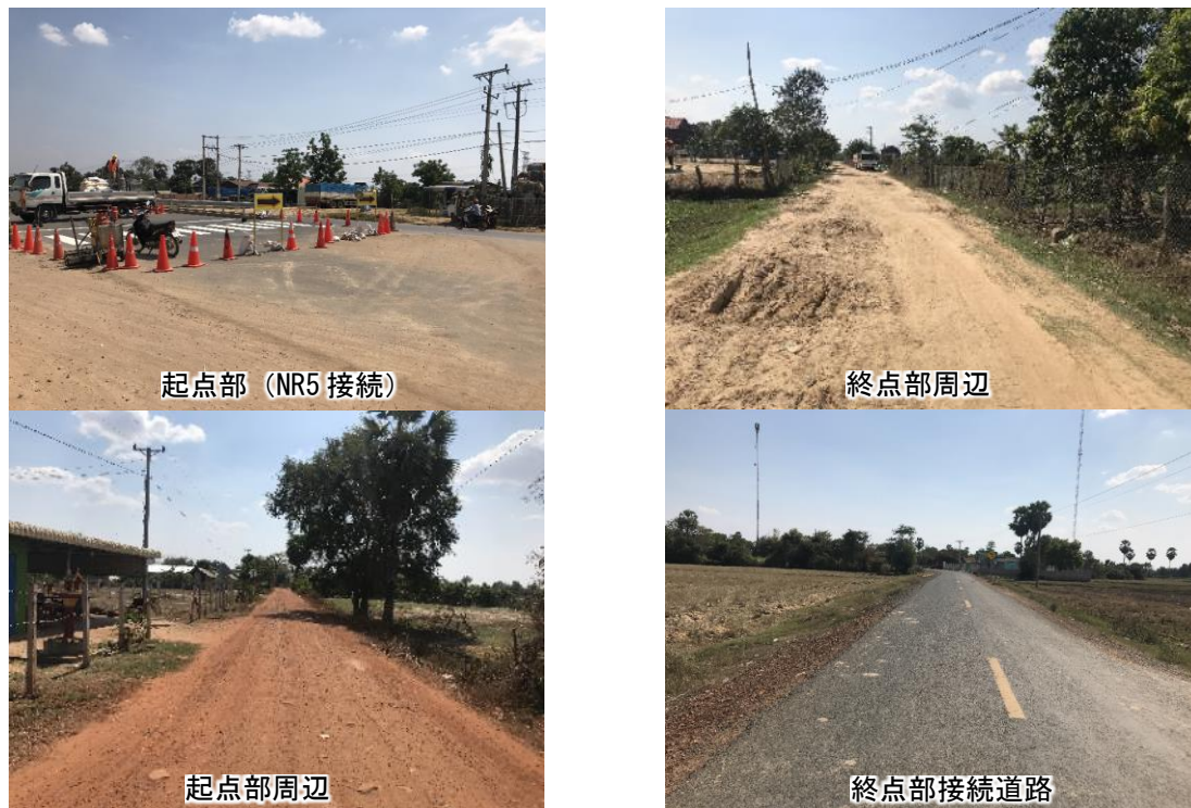
図 3.2-16 道路状況写真 (PS-4)
