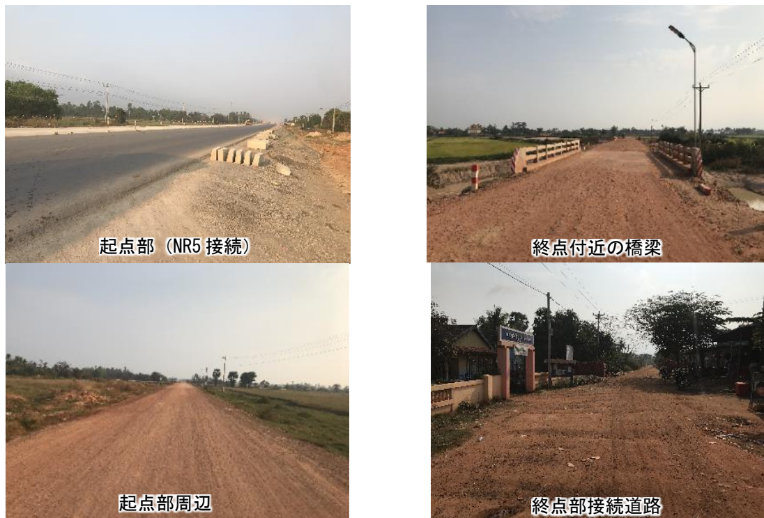
図 3.2-20 道路状況写真 (PS-9)
