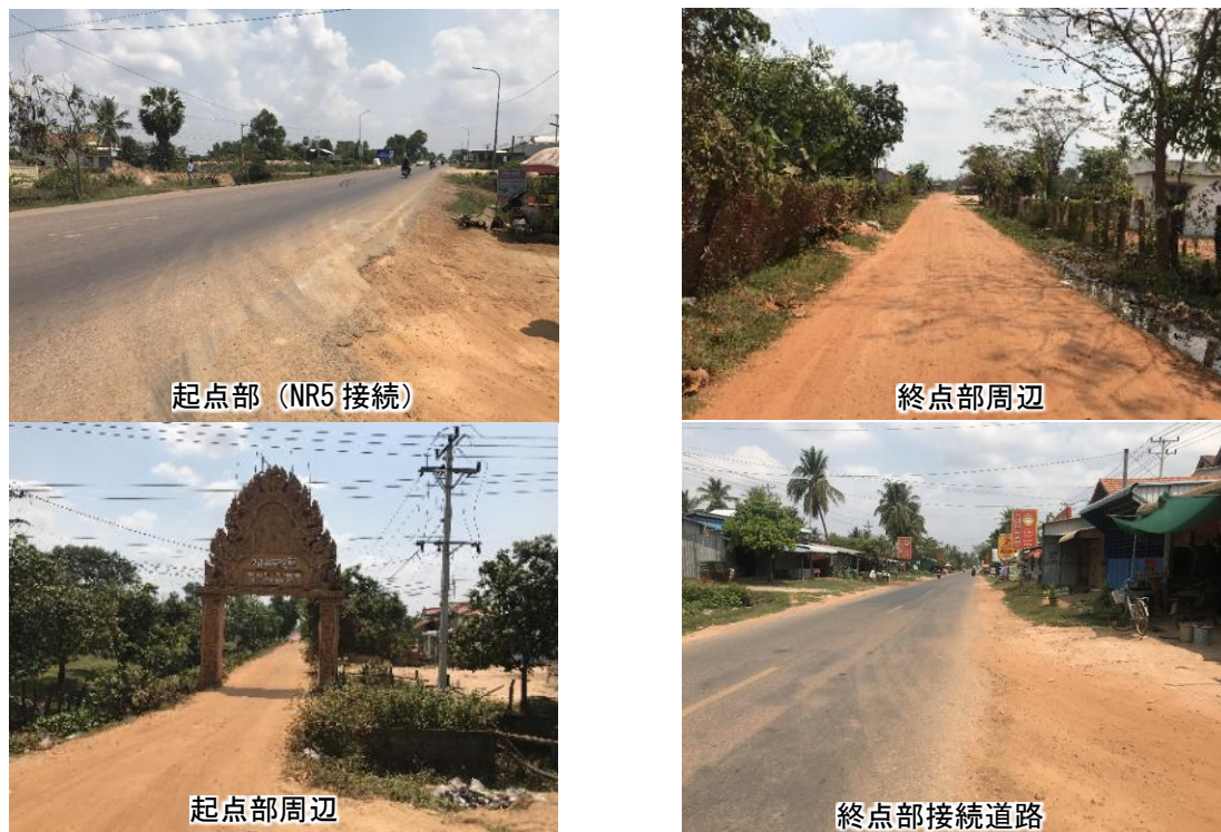
図 3.2-18 道路状況写真 (PS-6)
