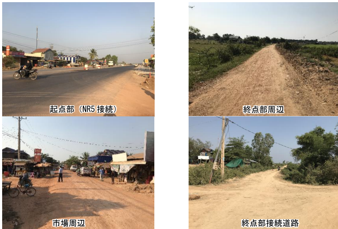
図 3.2-14 道路状況写真 (PS-2)
