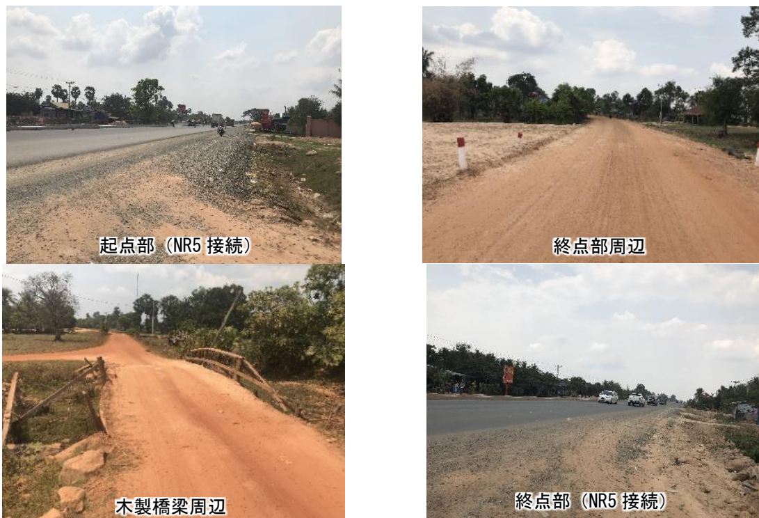
図 3.2-25 道路状況写真 (PS-14)
