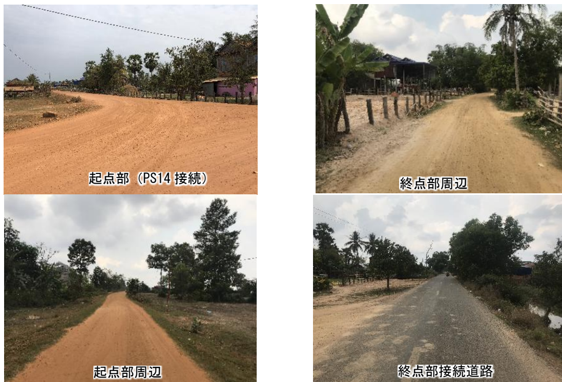
図 3.2-24 道路状況写真 (PS-13)
