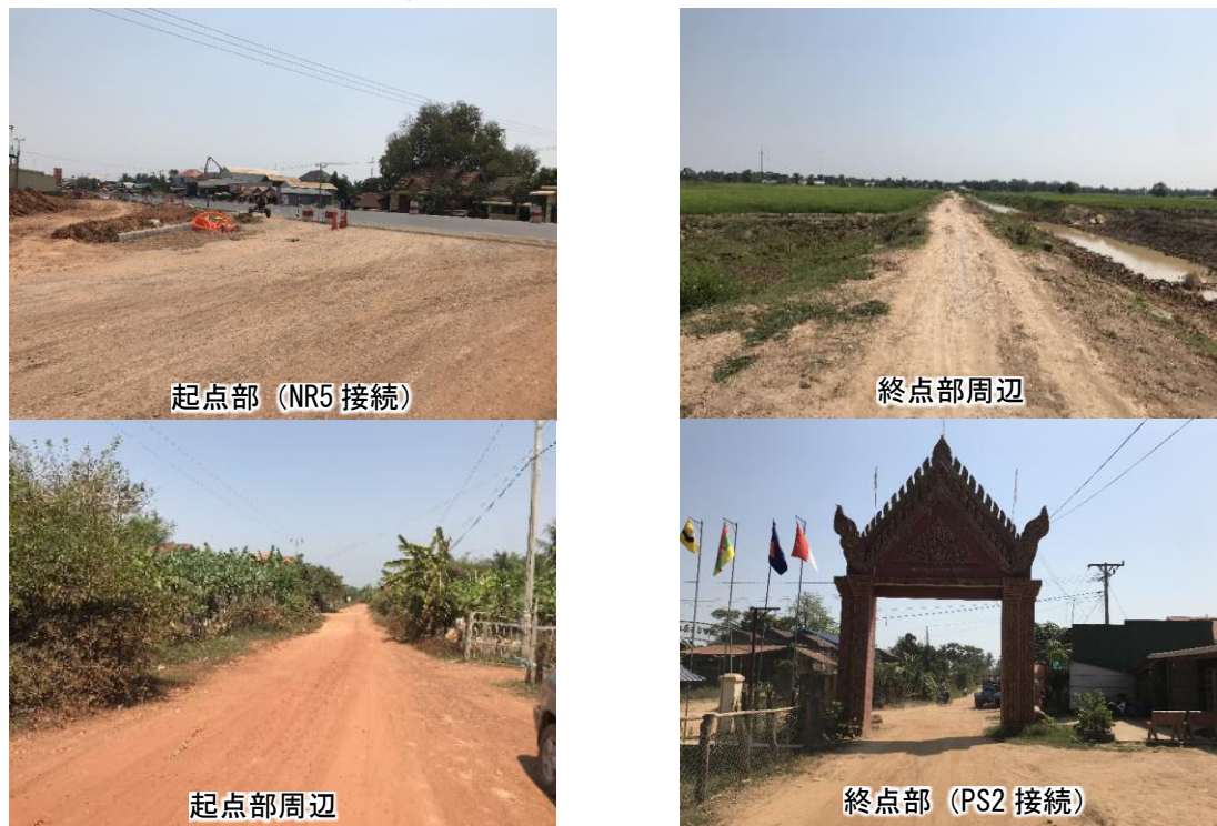
図 3.2-17 道路状況写真 (PS-5)
