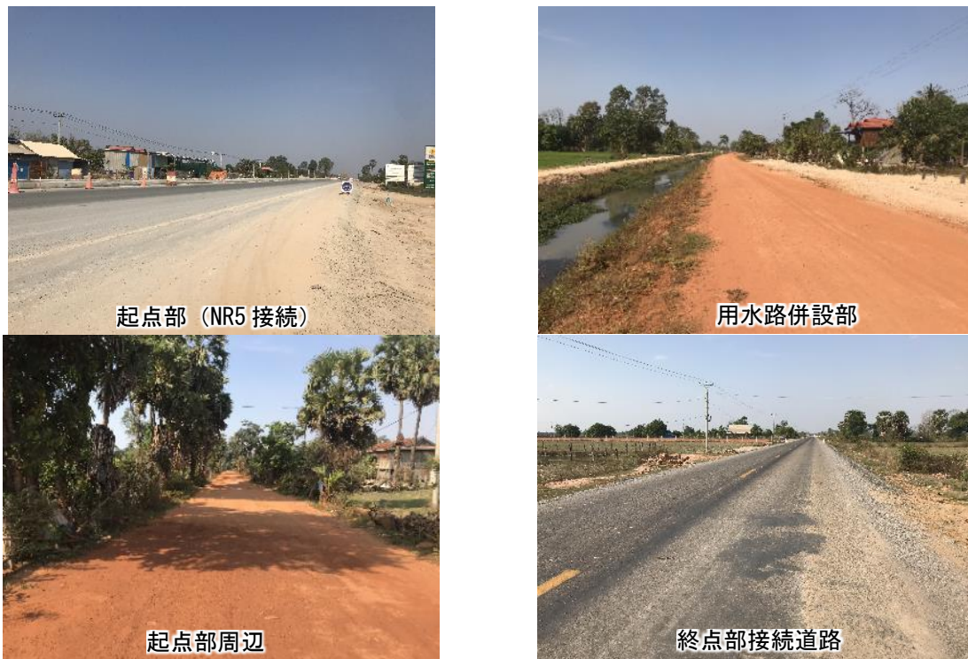
図 3.2-21 道路状況写真 (PS-10)
