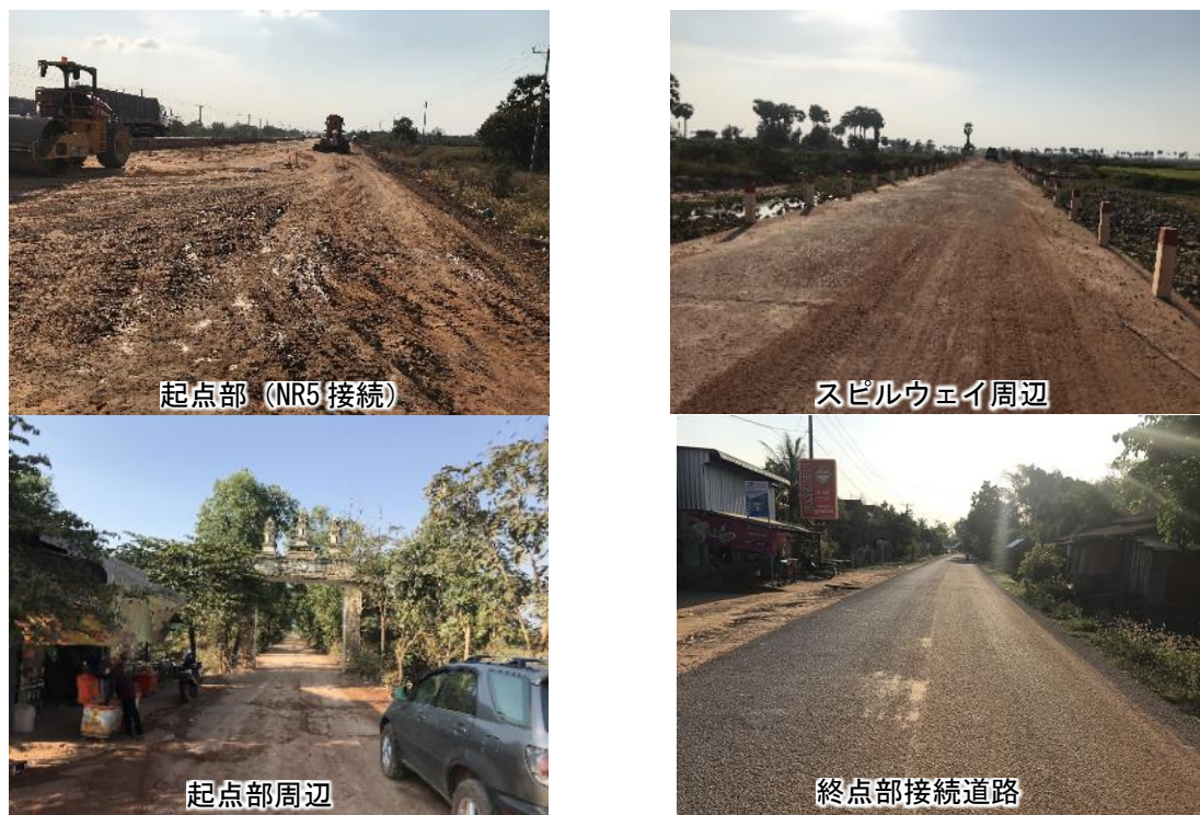
図 3.2-19 道路状況写真 (PS-8)
