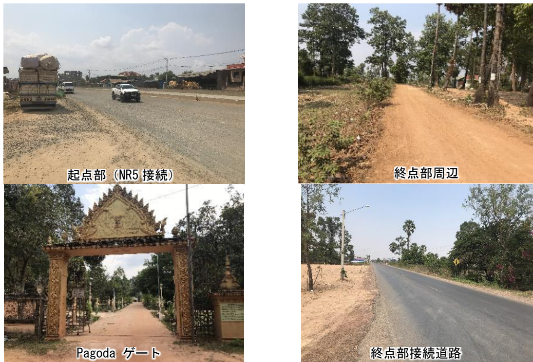
図 3.2-26 道路状況写真 (PS-15)
