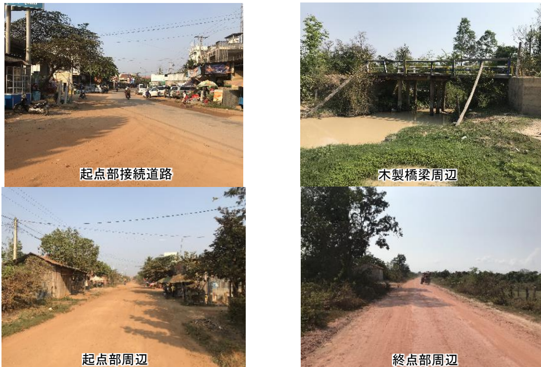
図 3.2-22 道路状況写真 (PS-11)
