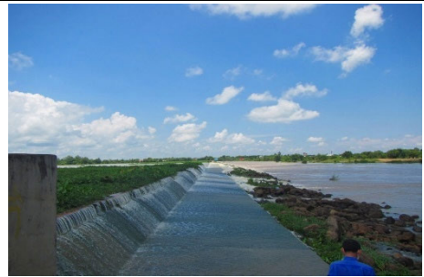
スタンチニットの横越流式洪水吐
