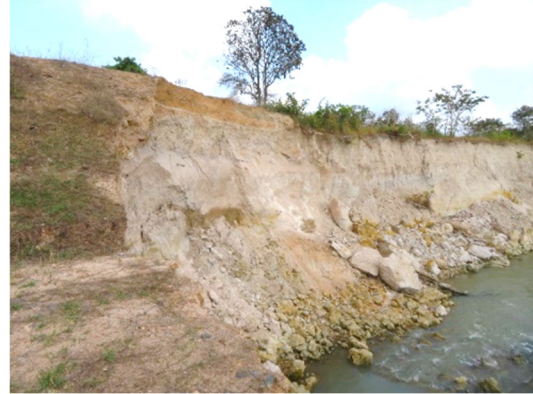
Pic-12 崩壊箇所の近景 (Lum Hach)
