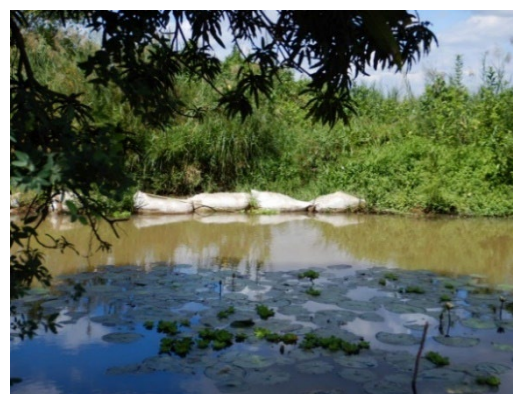
Figure 6.4.3 Seuil de prise d'eau fait de sacs remplis dans un périmètre traditionnel (Région de Morogoro)
