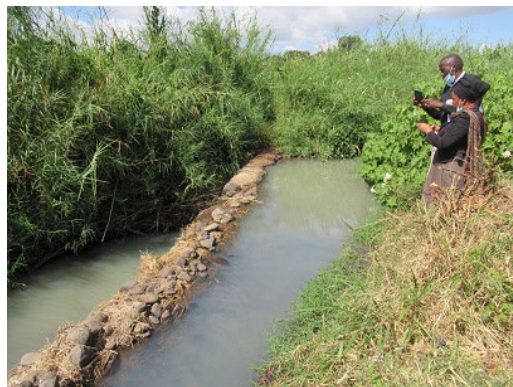
Figure 6.4.2 Seuil de prise d'eau fait de pierres dans un périmètre traditionnel (Région de Mbeya)
