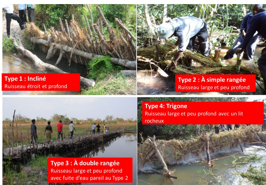
Figure 1.5.2 Quatre types de seuil simple (Zambie)
