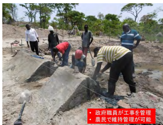
恒久堰（政府職員が工事を管理）
