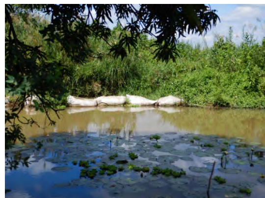
図 6.4.3 伝統的灌漑スキームの土嚢袋 による取水堰（モロゴロ州）
