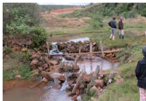
図 6.5.3 石積みタイプの簡易堰 （アムルニマニア県）
