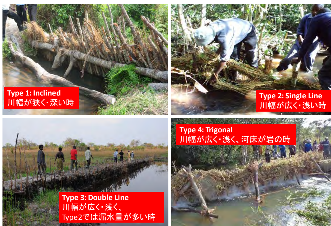
図 1.5.2 状況に応じた4タイプの簡易堰（ザンビア国）
