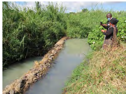
図 6.4.2 伝統的灌漑スキームの取水堰 (ムベヤ州)
