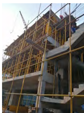
(a) 建設現場の様子
