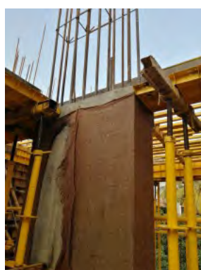
(b) コンクリート養生
