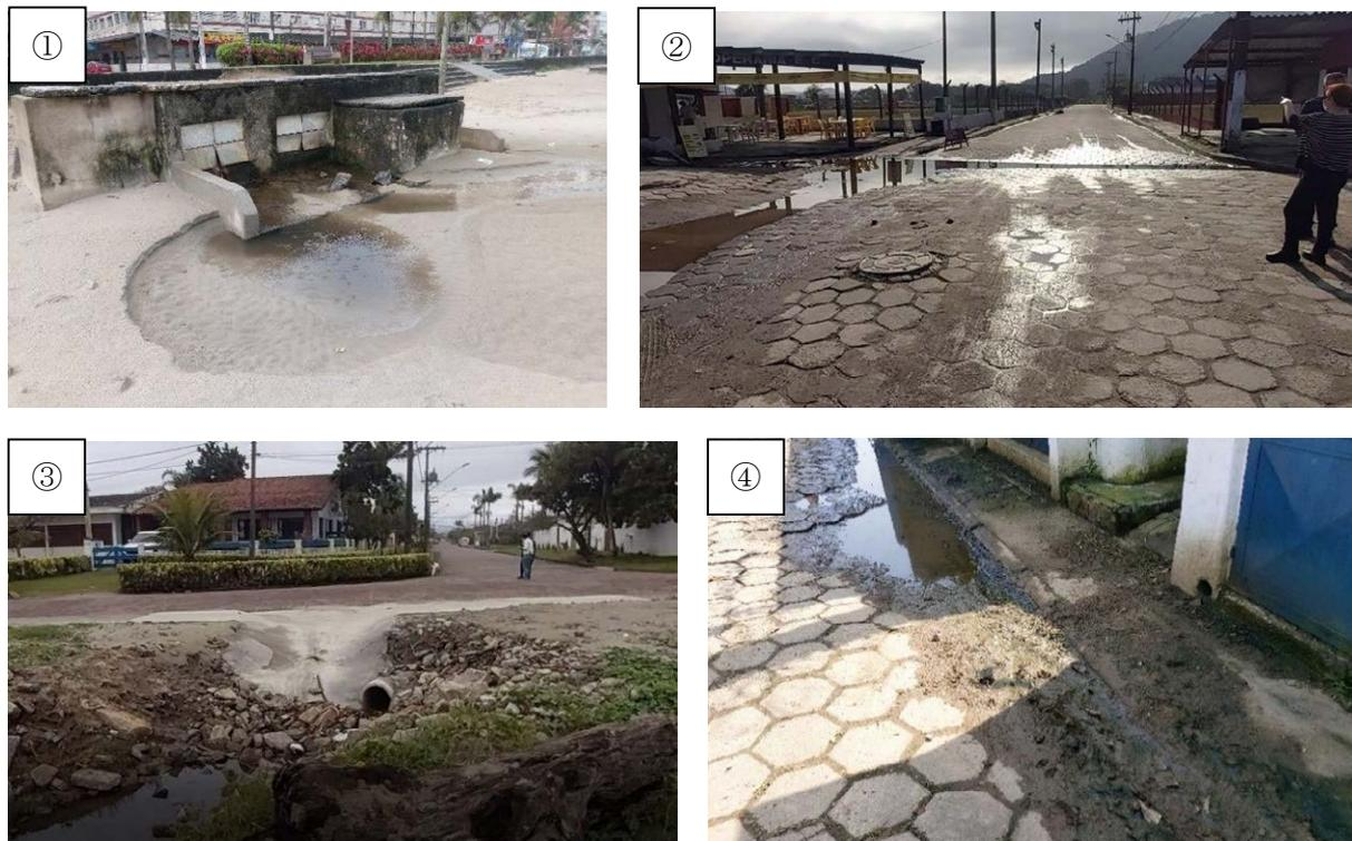
①(プライア・グランデ市): 雨水排水の海岸への放口, ②(モンガグア市): 側溝のみの整備でコンクリートブロック上に水が溜まる
