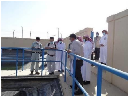
Diriyah ポンプ場の受水槽
