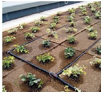
写真 4-20：圧力補正型点滴チューブ
