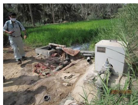
写真 4-15 : ルハサ地区農場での再生水吐出口
