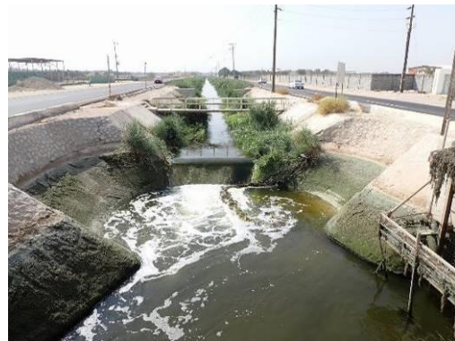
農業用水の排水路（ポンプ場の流入水）
