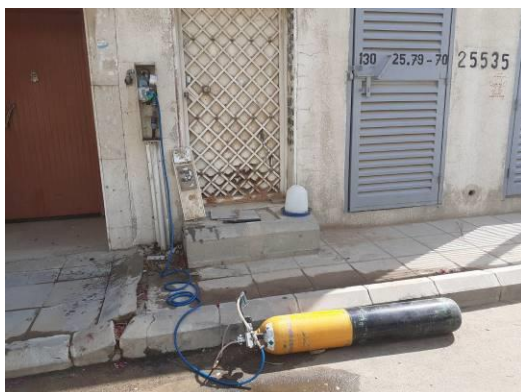
ヘリウムガスの管路への注入
