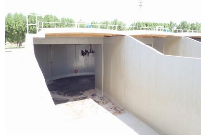
曝気槽の内部
