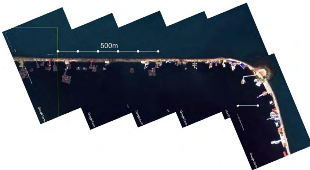
写真 4-1 既存防波堤(先端部付近)の状況
