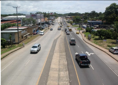
撮影：弊企業体、2021年撮影 Vista Alegre 駅東方向の状況
