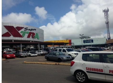
撮影：弊企業体、2021年撮影 Arraiján 駅隣接の既存商業施設
