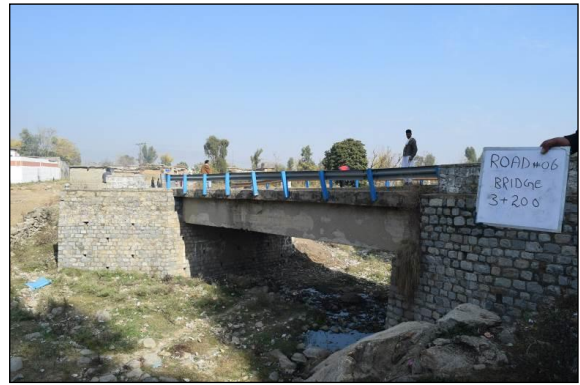
RC 桁橋 (No.6 Sta. 3+200)
