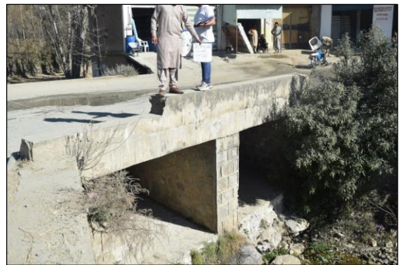
ボックスカルバート (No.12 Sta. 0+725)
