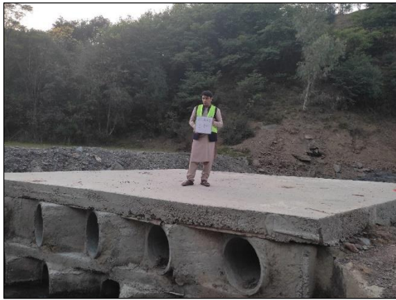
パイプカルバート (No.3 Sta 1+792)
