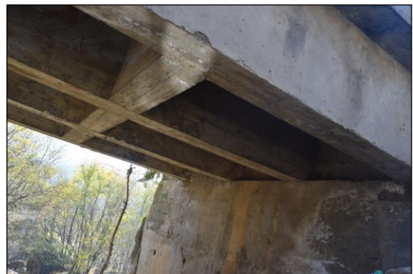
RC 橋 (No.13 Sta. 17+595)
