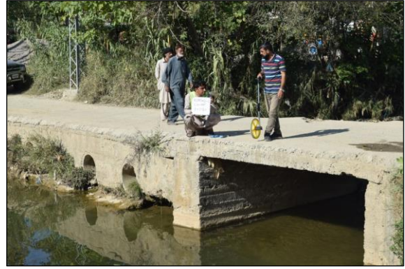
RC スラブ橋 (No.10 Sta 1+020)
