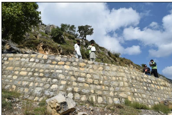
法面保護 (No.1 Sta. 5+650)
