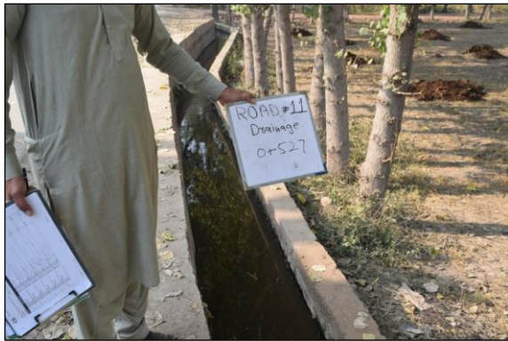
側溝 (No.11 Sta. 0+527)
