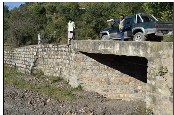
ボックスカルバート (No.2 Sta 2+295)
