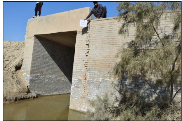
ボックスカルバート (No.8 Sta 3+420)
