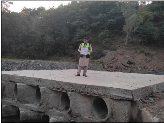
Pipe Culvert (No.3 Sta 1+792)
