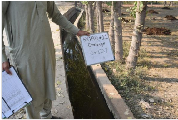
Ditch (No.11 Sta. 0+527)
