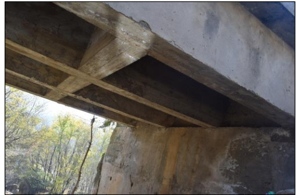
RC Bridge (No.13 Sta. 17+595)
