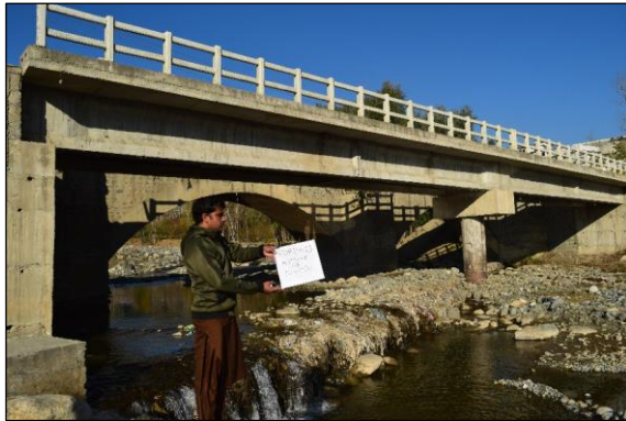
PC Bridge (No.13 Sta. 10+050)
