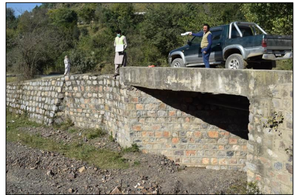
Box Culvert (No.2 Sta 2+295)
