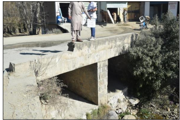
Box Culvert (No.12 Sta. 0+725)
