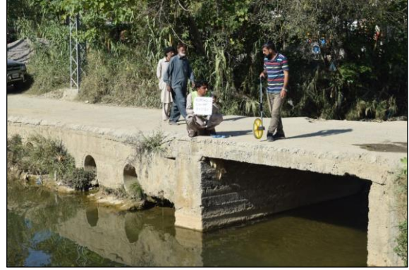
RC Bridge (No.10 Sta 1+020)
