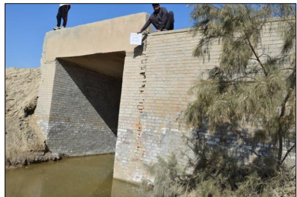
Box Culvert (No.8 Sta 3+420)
