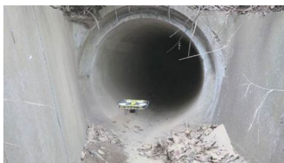
図-51 配管内を飛ぶマイクロドローン
