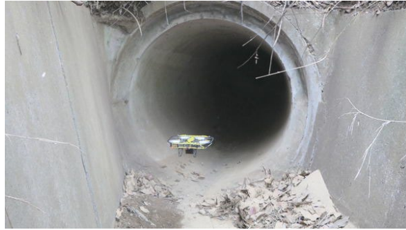
Figura-51 Microdrón volando en el interior del ducto
