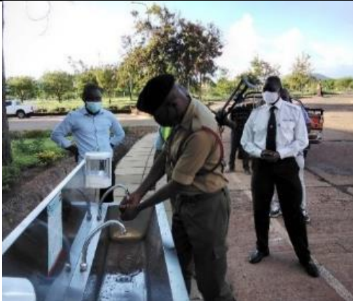
新たに設置された膝押し式シンクの手洗い場 (Taveta BP、ケニア)
