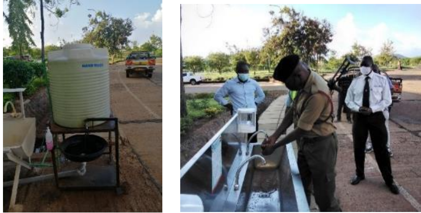
古い手洗い場（左）と新しく設置された手洗い場（右）（Taveta BPにて）
