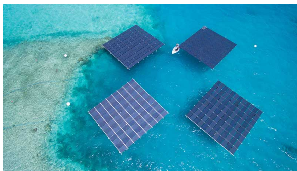
浮体式洋上太陽光発電システム・SolarSea
