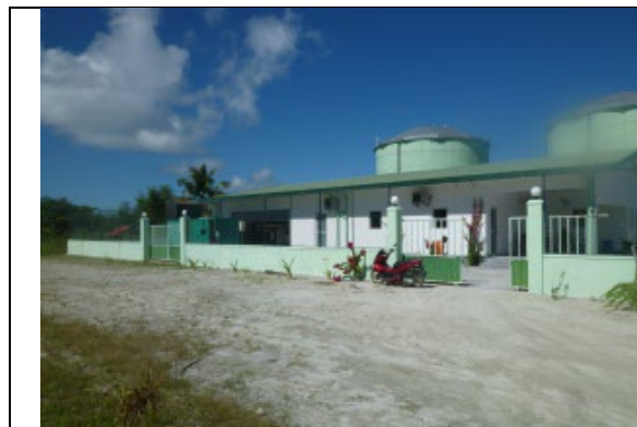
L. Fonadhoo 島浄水場・外観
