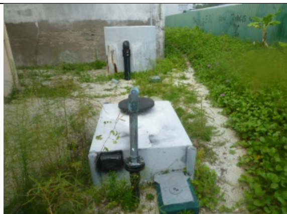
K. Hurra 島浄水場・取水井
