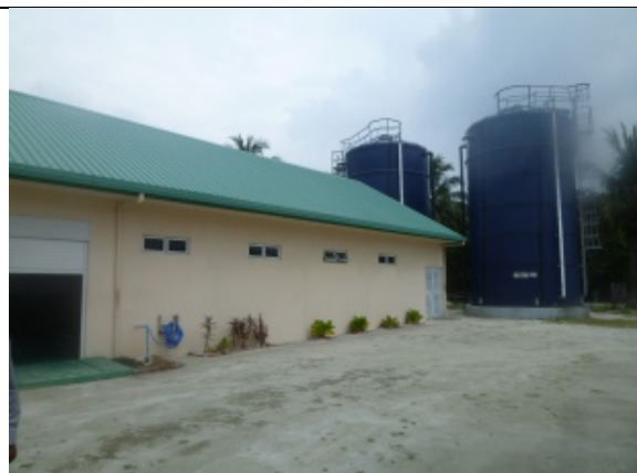
K. Hurra 島浄水場・外観
