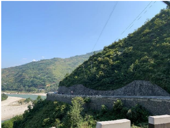
スンコシ川沿いの現道状況
