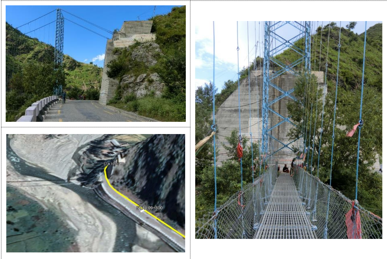
図 16.2-9 第三工区 109km+700 拡幅困難区間
