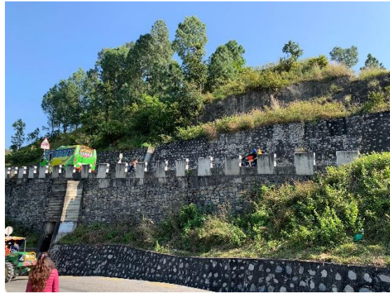
沿道の土地利用が難しい急傾斜地
