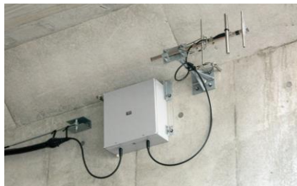
図 13.6-17 無線通信補助設備
