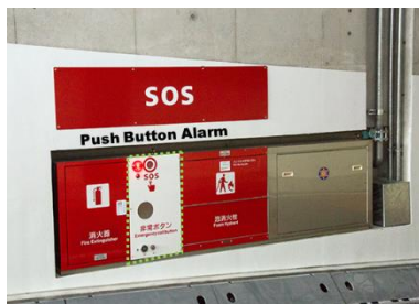
押ボタン式通報装置（消火器一体型）
