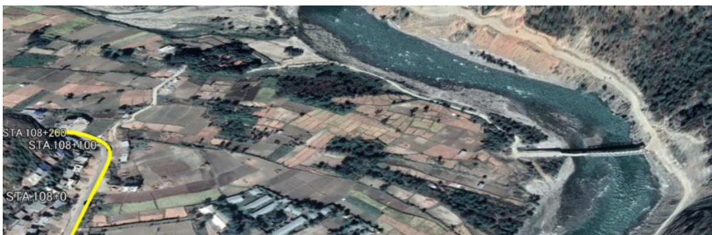
3) 108kmkm+100 車両通行可能な既存渡河橋梁 (スンコシ川)
