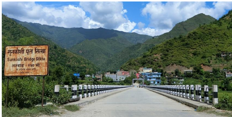
2) 96kmkm+200 車両通行可能な既存渡河橋梁 (スンコシ川)
