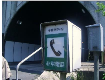
非常電話（トンネル坑口部）
