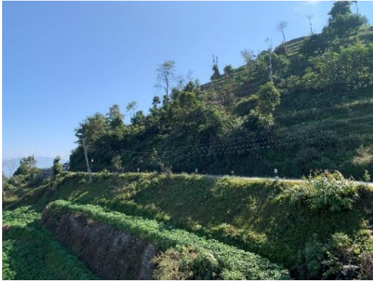
二次林による傾斜地を横切る現道
