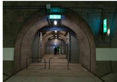
避難通路（避難連絡坑）
