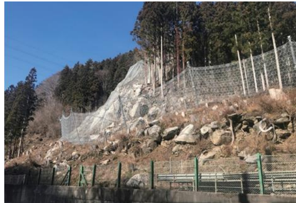
図 17.4-2 高エネルギー吸収柵の本邦事例（参考図）
