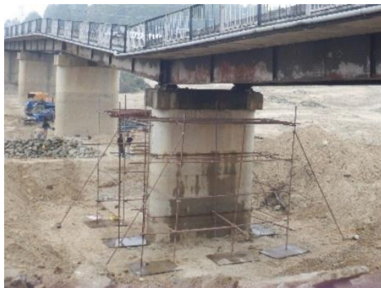
図 5.1-11 下部工沈下の状況
