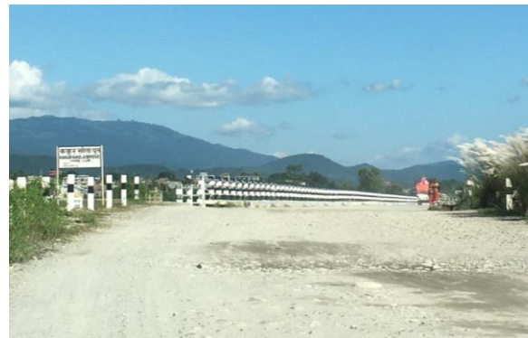
橋梁建設区間（未完成のアプローチ道路）
