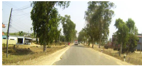
ii) 平坦地域の道路状況
