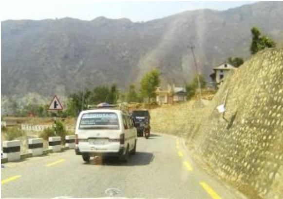
i) 第三工区の道路状況
