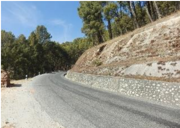
i) 第四工区の道路状況
