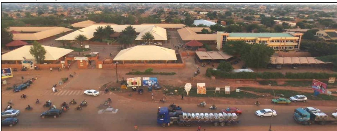
シャルル・ド・ゴール大通りから見た施設全景
