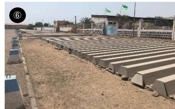
Zone à canal ouvert avec couvercle. La canalisation de drainage est aménagée sur une largeur de près de 10 m.
