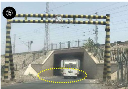
Largeur de la route insuffisante sous la voie ferrée
