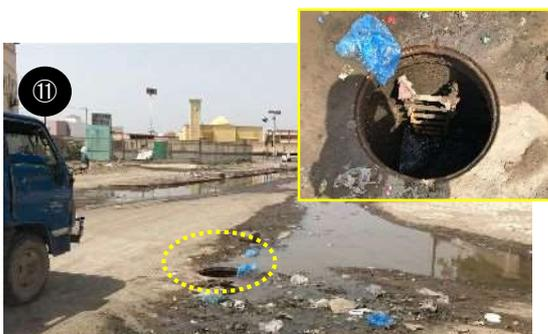
État d'un trou d'homme de la ville. Le couvercle est détaché et l'eau du drainage routier s'y écoule.
