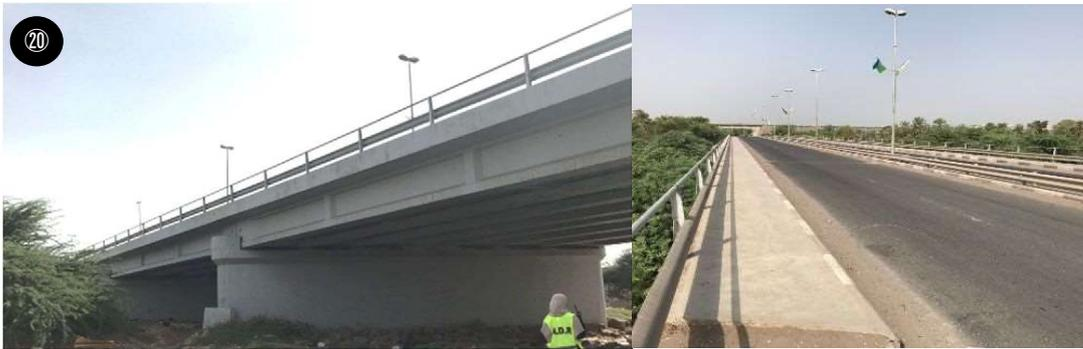
Le pont d'Italie est le seul pont routier de la ville. Construit en 1993, il a été réparé en 2017 par une entreprise chinoise. La circulation des véhicules lourds y est actuellement réglementée, notamment en raison de craintes quant à sa résistance.
