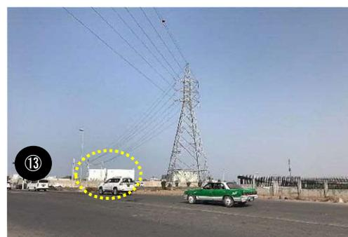
Installations électriques près de la route de Palmeraie. La ligne de transport de l'électricité traverse la route à une hauteur d'environ 18 m.
