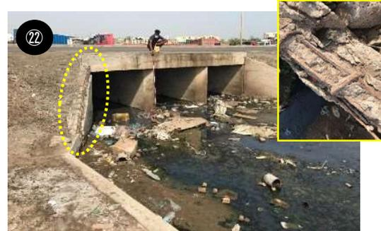
Les dommages sont notables, dont notamment la corrosion des armatures (probablement par le sel) et le détachement du béton.
