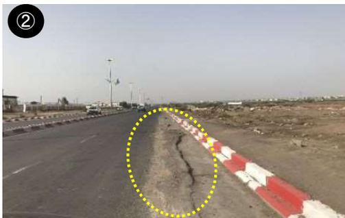
Rétrécissement de la largeur disponible pour la circulation à cause des nids-de-poule dans l'accotement
