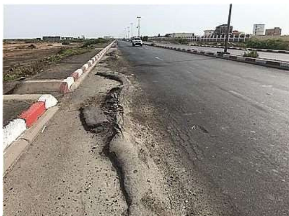
ジブチ市内道路状況 （わだち損傷）
