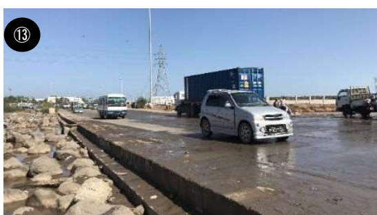
洗い越し構造。降雨時には冠水し、交通が途絶する
