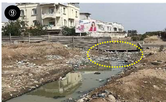
洗い越し構造。降雨時には冠水し、交通が途絶する
