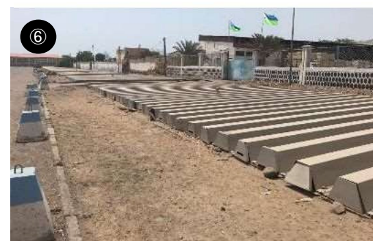
蓋掛けした開水路区間。水路幅は10m 近く整備されている。
