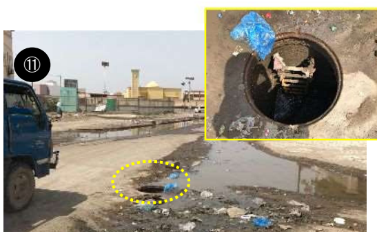
市内マンホールの状況。蓋が外されて路面排水が流入している
