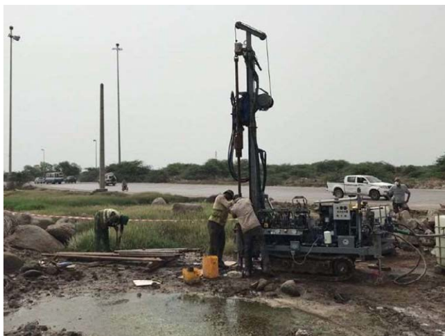
図 2.1.9 地質調査状況（左：パルマレ道路、右：ナガット道
