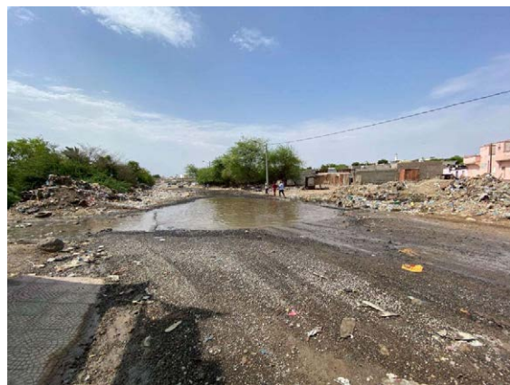
ジブチ市内道路状況 （未舗装、陥没、滞水）
