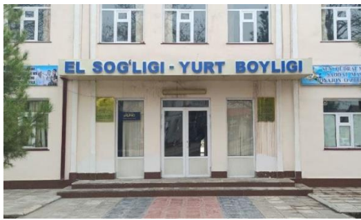
Карманинская Центральная районная больница, вход
