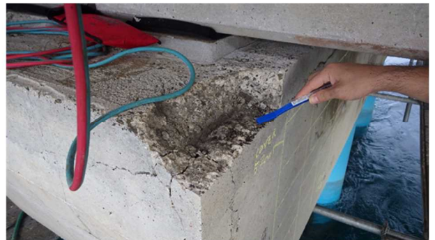
写真 3-3 カルバート及びミナト橋パイルキャップの鉄筋露出状況
