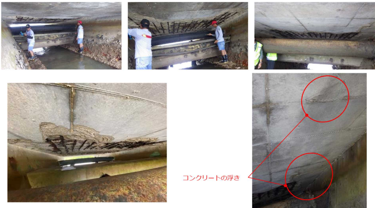
写真 5-1 アイライカルバート現地状況
