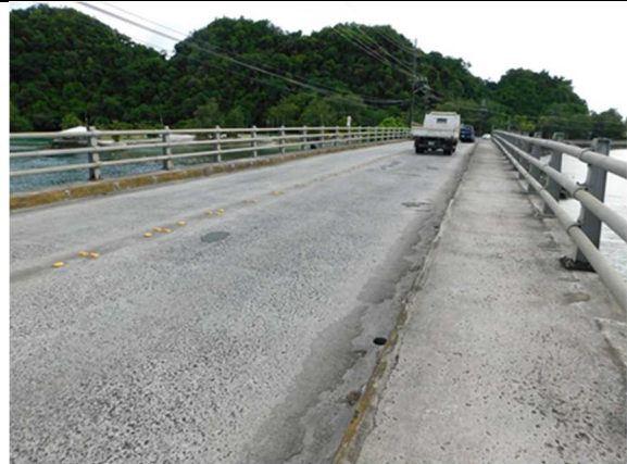
ミナト橋 橋面
