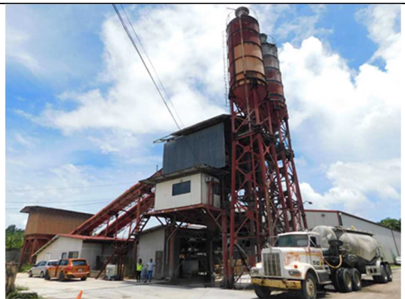
生コンプラント
