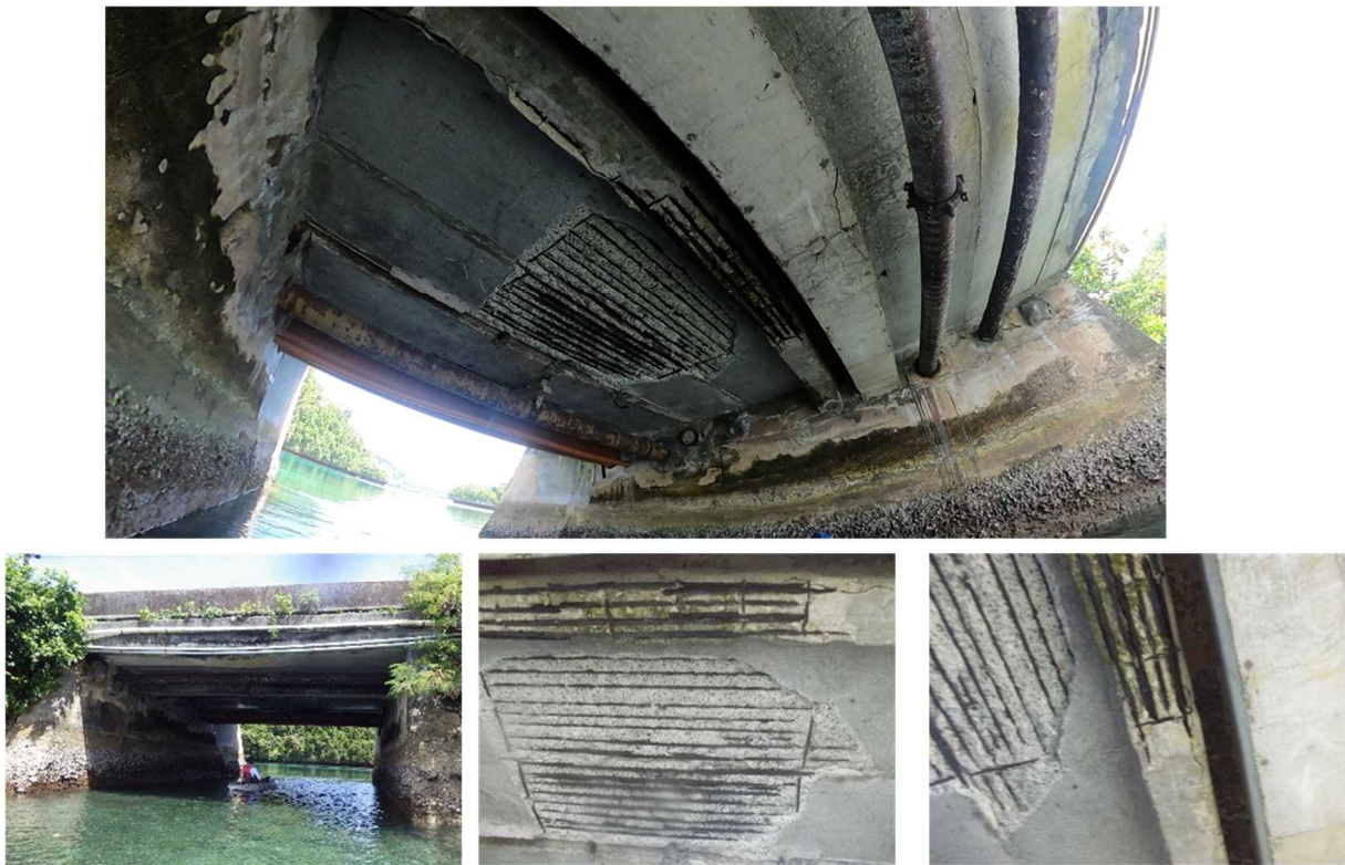
写真 5-3 MaC-Cu-1 現地状況
