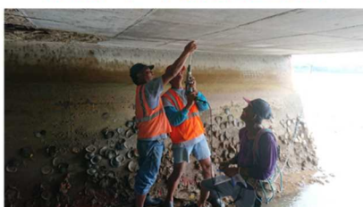
写真 3-4 カルバート及びミナト橋の試料採取状況
