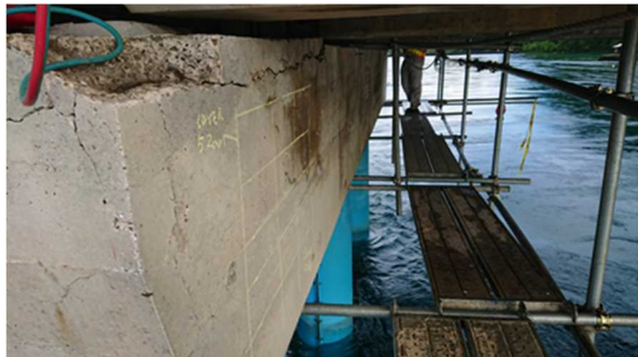
橋脚周り足場
