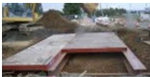
図 5-9 覆工板+H 鋼による仮橋構造
