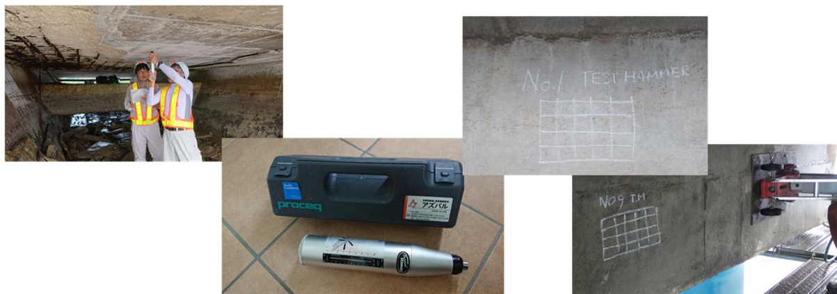
写真 3-2 非破壊強度試験状況
