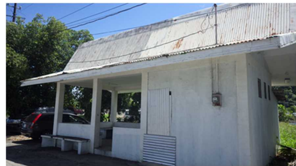
北側ルート上のベンチ+トイレ
