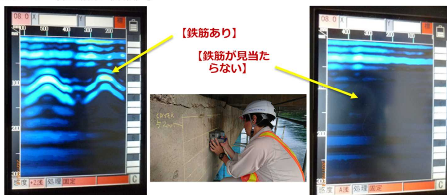
写真 3-1 鉄筋探査状況
