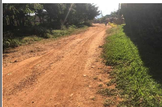
写真6.学校前の道路状況(School Road)
