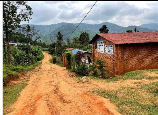
写真6.学校前の道路状況(School Road)
