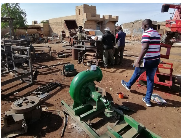
Atelier de réparation des machines de construction et des pompes à eau (beaucoup d'ateliers sont répartis sur une vaste zone) Ross Béthio, Région de Saint-Louis
