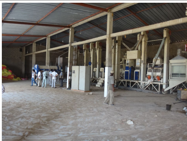
サンルイ州ダガナ県 既存精米工場
