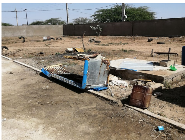
ルーガ州ケベメール県 漁業関連既存施設(井戸、一時保存用ヤード)
