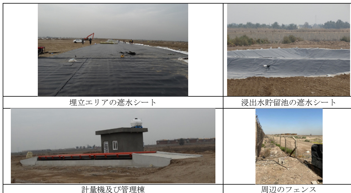
図 4-15 建設中の Buaitaih 処分場の設備の写真 (2021 年)
