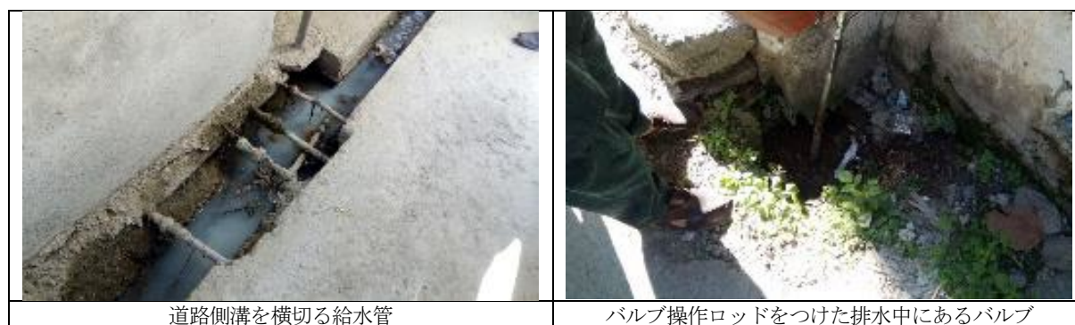
図 4.5.4 道路側溝を横切る給水管と排水中にあるバルブ
