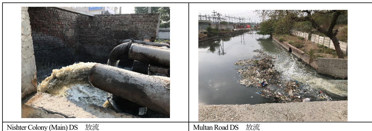
図 6.2-5 DS から雨水排水路への未処理下水の放流
