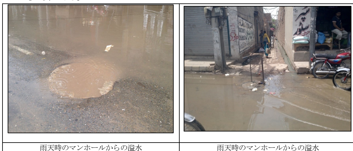
図 3.5-6 雨天時のマンホールからの溢水
