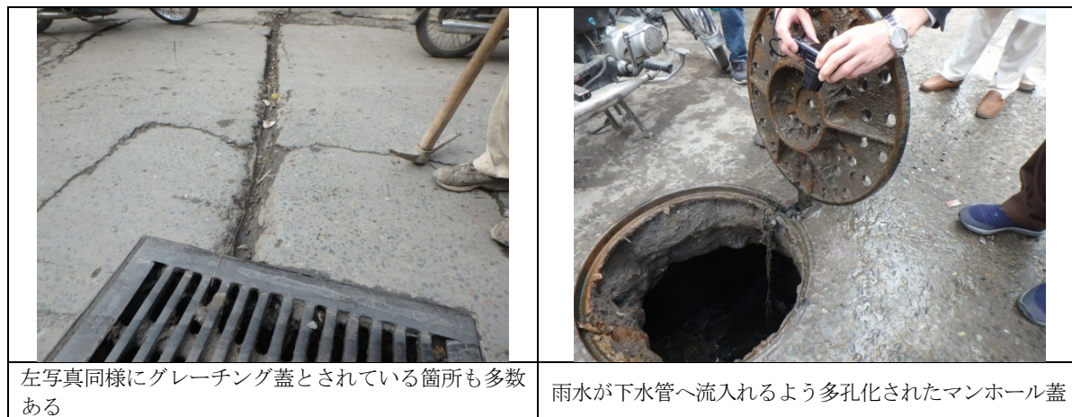
図 6.3-3 グレーチング蓋と多孔化されたマンホール蓋
