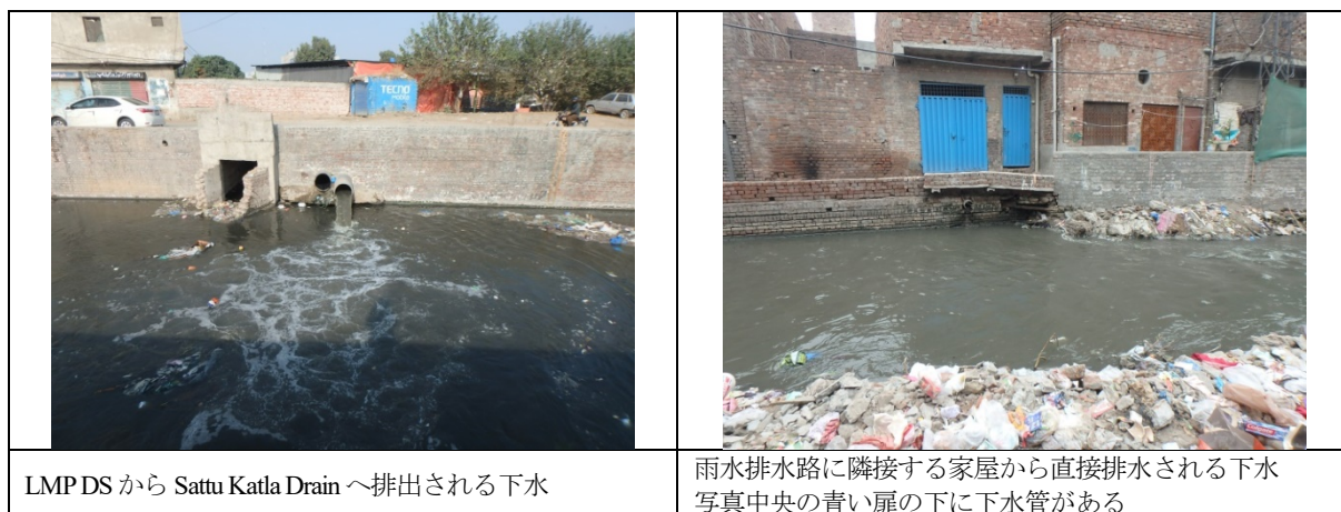
図 6.3-6 雨水排水路への下水流入
