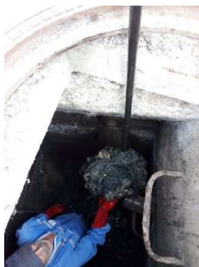
人力でマンホール内の堆積物を清掃
