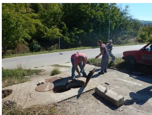
閉塞したポンプの引き上げ作業状況
