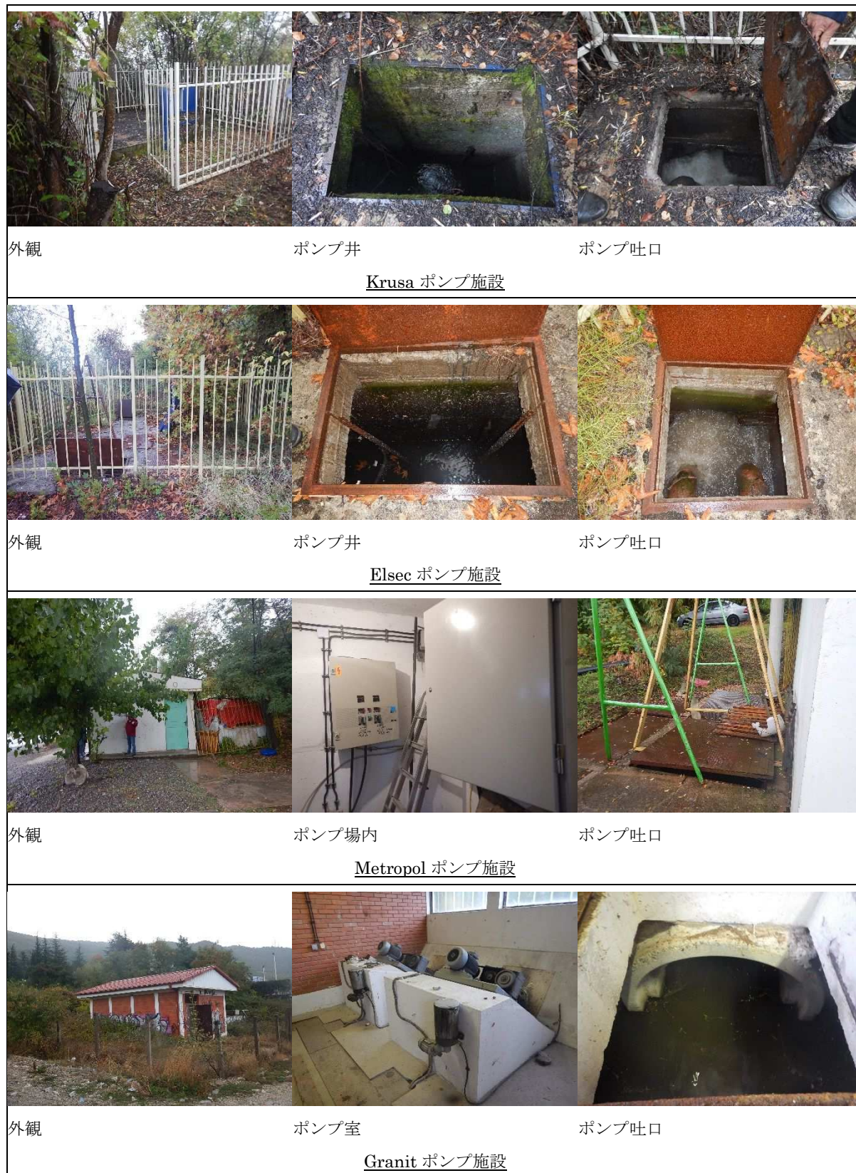
写真 3.2 一次管渠に設置されているポンプ施設（1/4）
