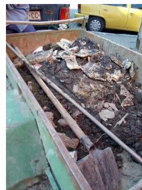
管路内から収集された堆積物
