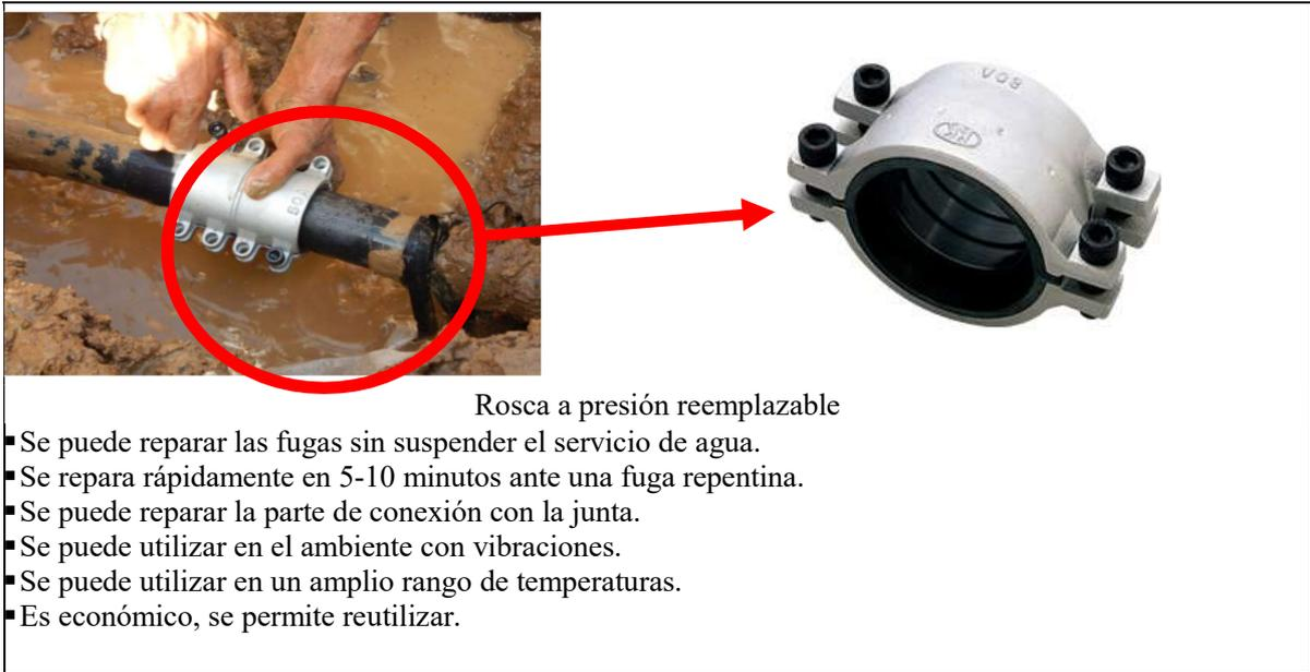
Figura 5-3-2 Reparación de fugas con abrazadera de presión
