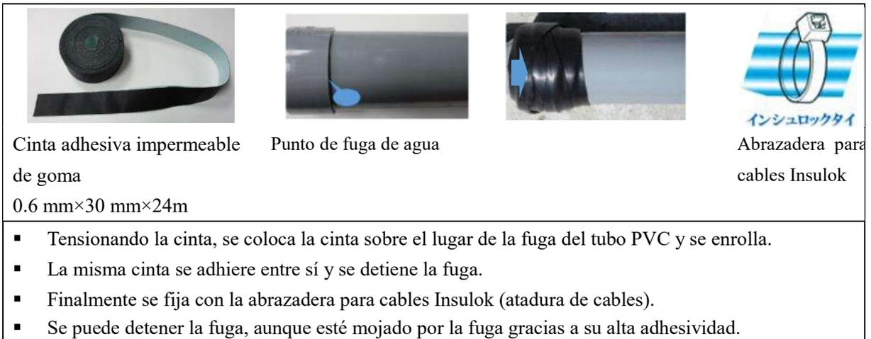
Figura 5-3-3 Procedimiento de reparación de fugas con cinta adhesiva impermeable de goma
