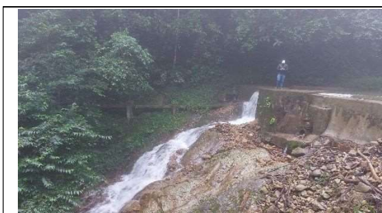
El Aguacatal Diversion Dam
