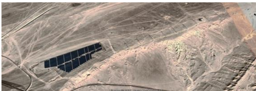
Зураг 3-17: Замын-үүд сумын нарны цахилгаан станц
