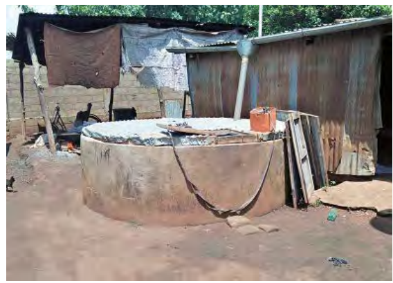
雨水溜 (アプラホエ市街地)
