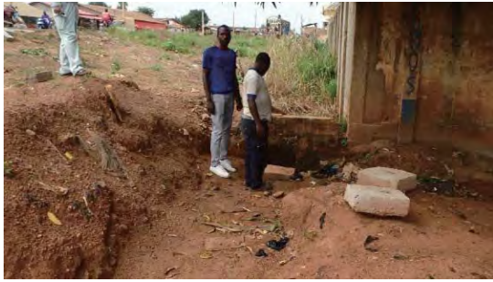
既存管路の布設箇所 (ドボ)
