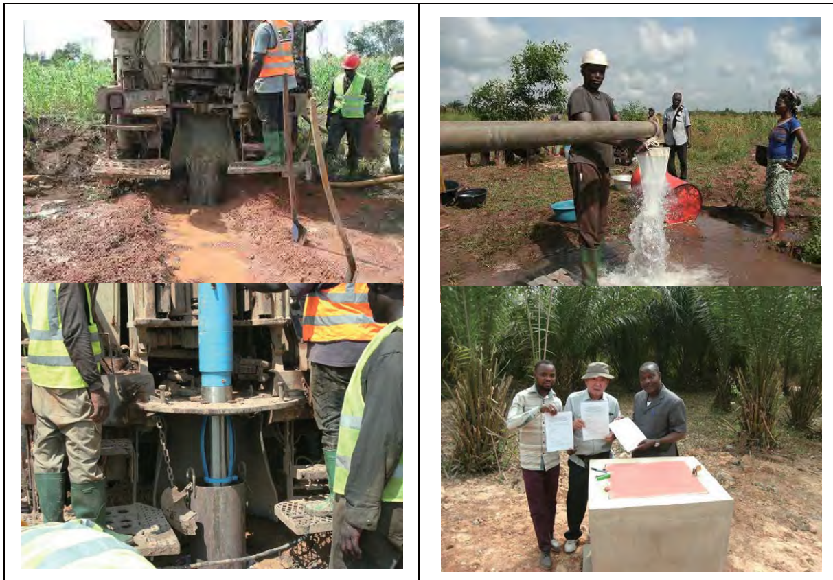
図 2.2.2.10 試掘井建設・引渡し状況
