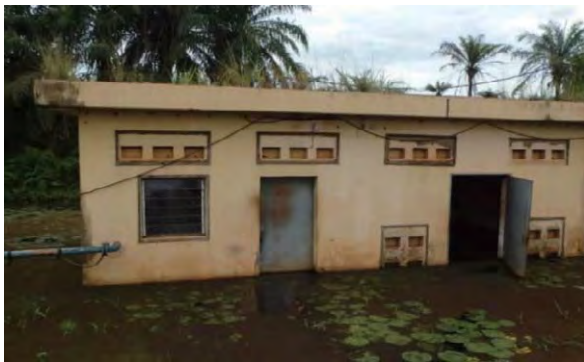
既存の井戸ポンプ管理棟 (ドボ)
