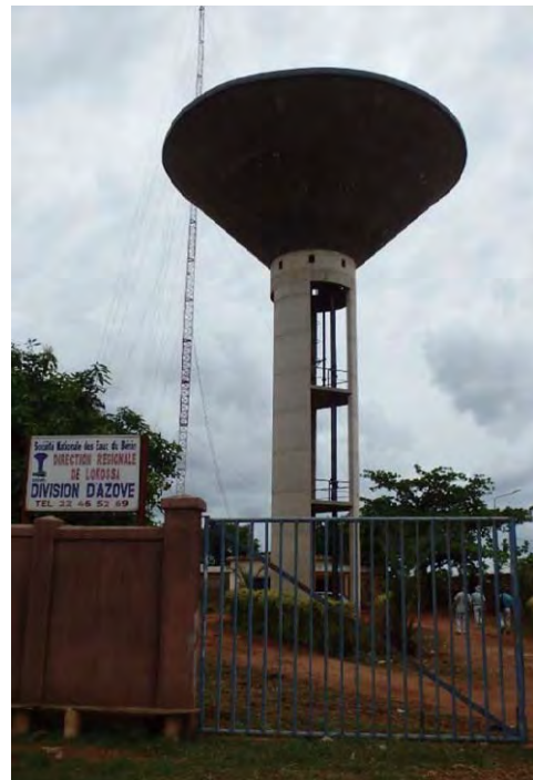
既存の高架水槽 (アゾベ)
