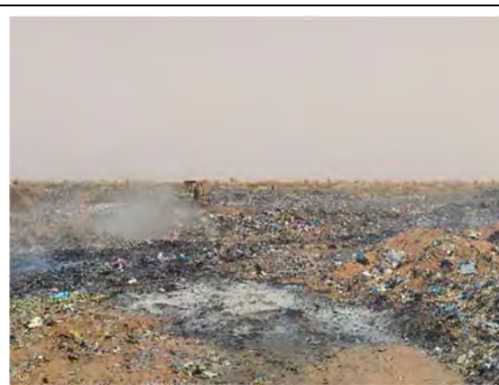
シェイカン処分場の現状 重機による転圧及び覆土が試みられているものの十分ではなく、野焼きによる煙が立ち込めている。
