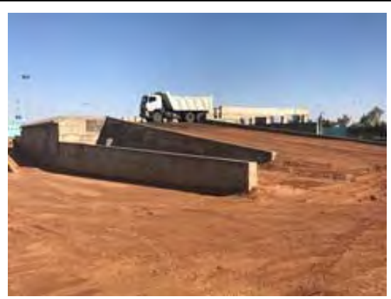
ワデフィア新中継施設 プラットフォームまで のアクセス道路状況 (未舗装)
