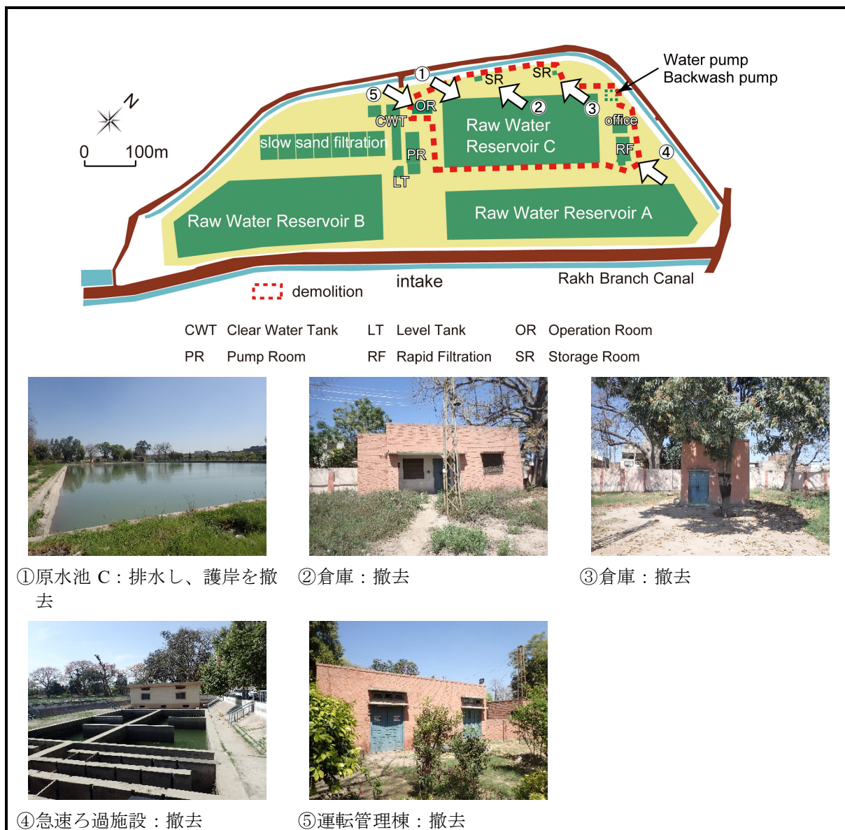
図 3-38 OJK 浄水場の撤去する既存施設
