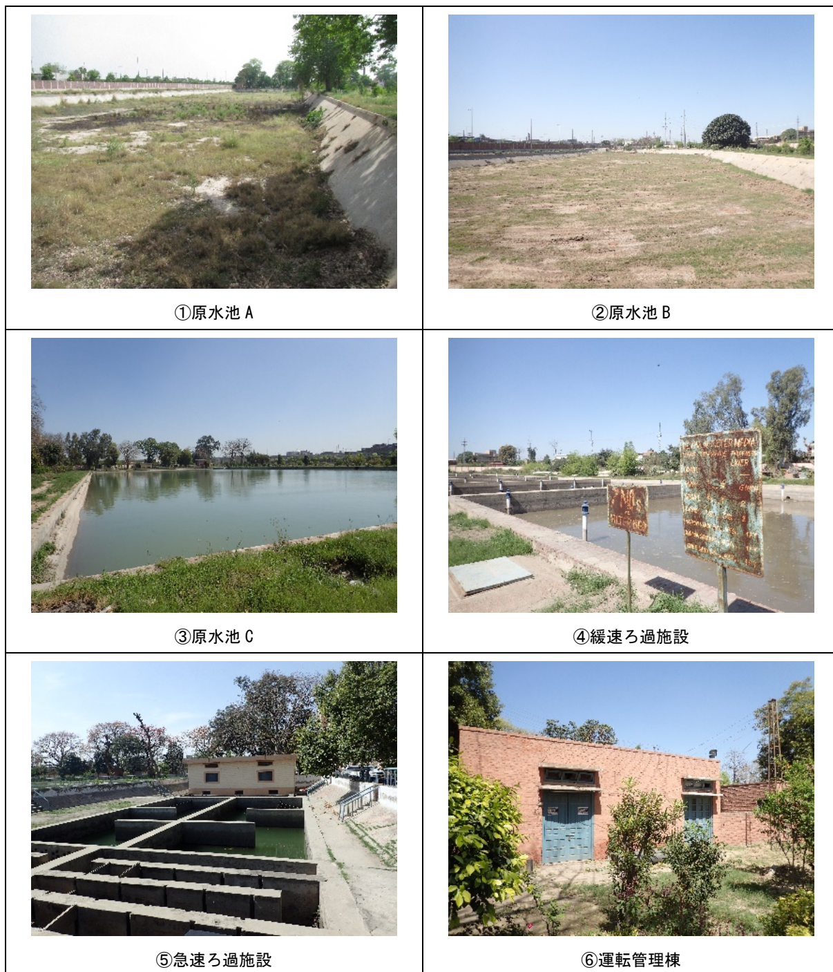
図 2-5 OJK 浄水場の既存施設の写真
