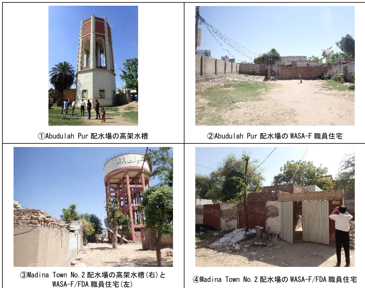
図 2-8 配水場の既存施設の写真
