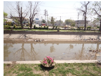
⑯送水管ルート：ラック灌漑水路は水管橋により横断する。
