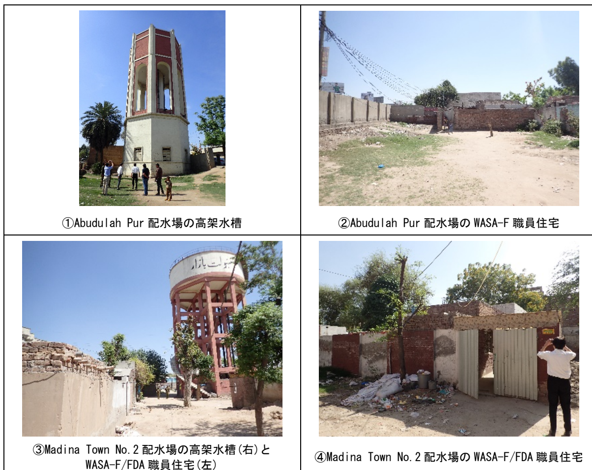
図 2-8 配水場の既存施設の写真
