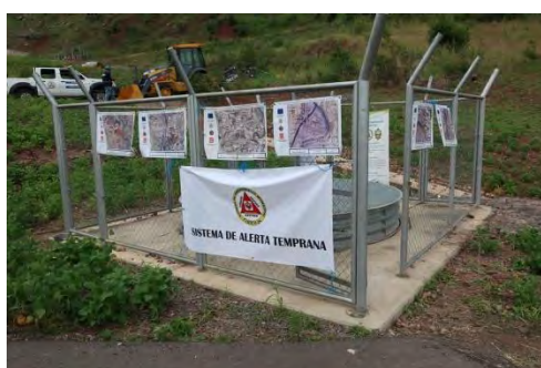
Obra de prevención de deslizamientos (Pozo recolector) Proyecto de asistencia financiera no reembolsable de JICA
