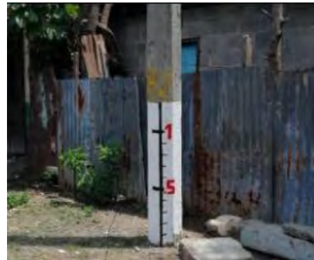
Se pintó la marca de aprox. 1 m en el poste de electricidad en un lugar llamativo.
