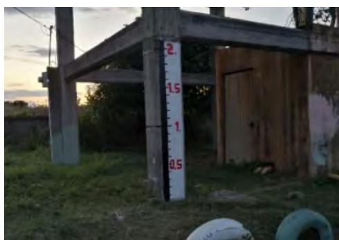
Villa Guadalupe の給水塔には複数方向から目視できるよう2カ所設置した。
