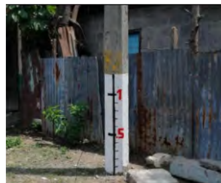
人目に付く電柱に約1m程度の目盛りを塗装した
