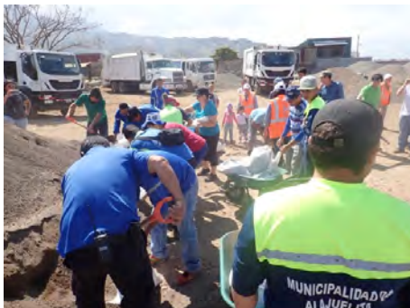
土のう演習で実際に土嚢を作る様子 (2019年2月)
