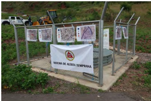
JICA 無償資金協力事業の地すべり対策工 (集水井)
