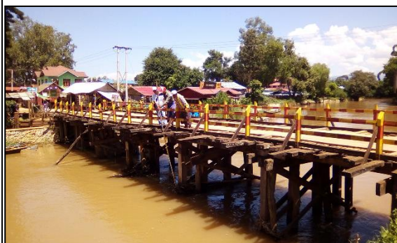
Upper Balu 川の橋に取り付けられた水位計
