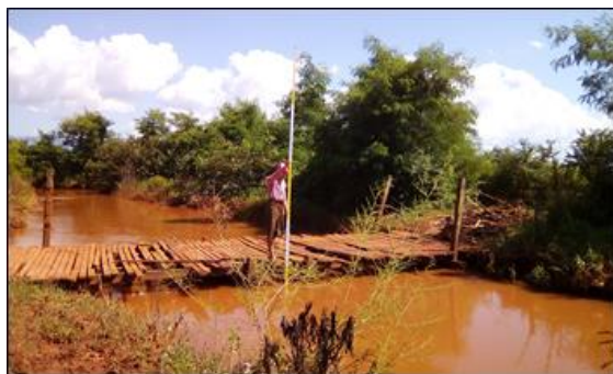
Negya 川の橋に取り付けられた水位計
